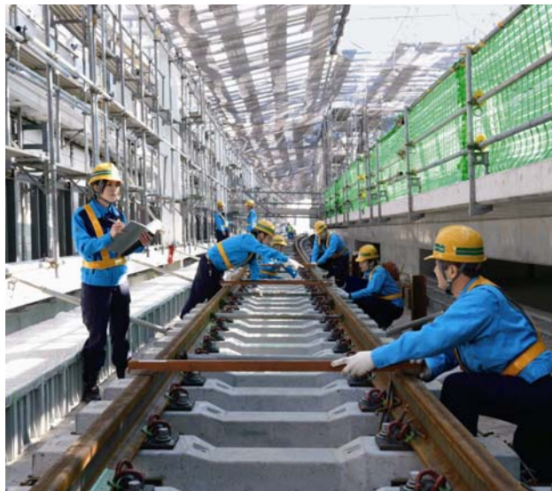
石神井公園駅上り線工事現場 (2009年11月上旬撮影)
