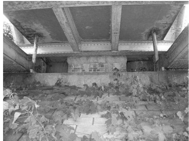
(f) 西橋台 (護岸積みブロックで隠れている)
