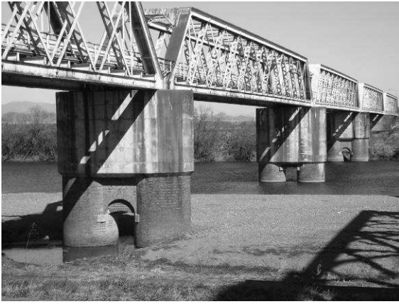
写真-1 旧揖斐川橋梁全景
