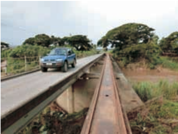
写真-4 道路橋（左）に併設された単線鉄道橋（右）。軌道部分に鋼板がボルトで固定されているが、手すりがなく歩いて渡るのは怖い。（北東を見る。2014年2月22日）
