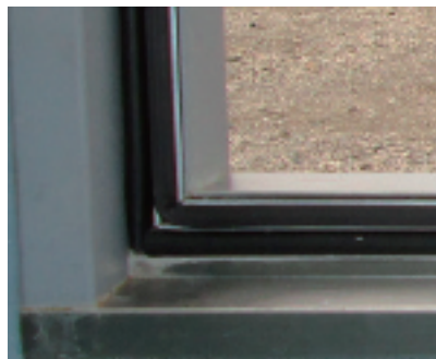
図2 枠に取り付けた2重のゴム
