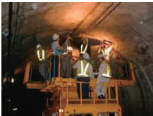
【トンネル打音調査】
