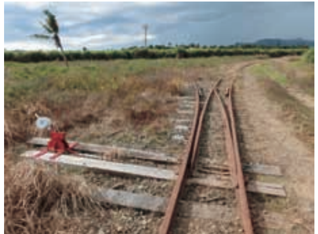
写真-2 サトウキビ畑の中を走る超狭軌のサトウキビ輸送鉄道。分岐器はダルマ=ポイントで転換する。収穫期でないため線路を使用していないのでレールは錆びている。（2014年2月22日）
