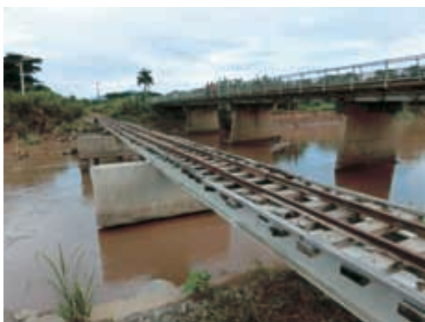
写真-11 2013年春のナワカ川の洪水で流され、その後突貫工事で復旧されたサトウキビ輸送鉄道の橋梁（手前）と右奥に見えるのは道路橋。(2014年2月22日)
