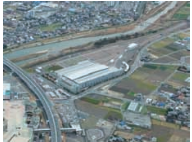
図1 橋本車両基地 航空写真
