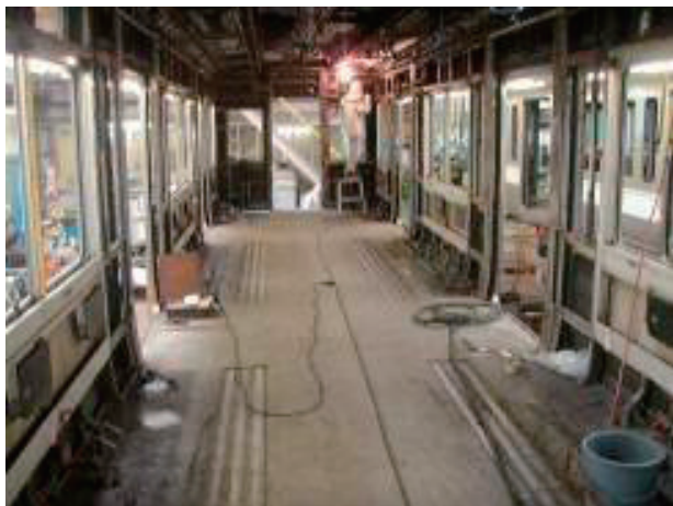
写真-5 内装取外し状態
