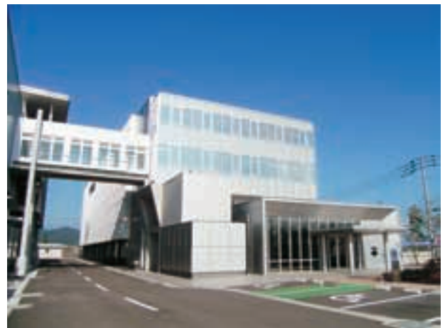
図2 管理棟と工場棟への連絡通路
