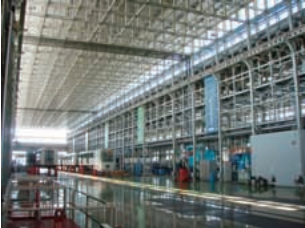
図3 工場棟の自然採光と塗床
