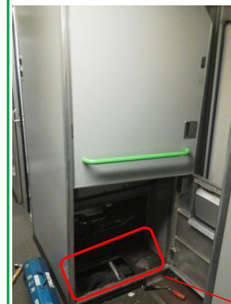
床板を取り外した状態
