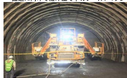
南アルプストンネル(早川非常口) 本線トンネルの掘削
