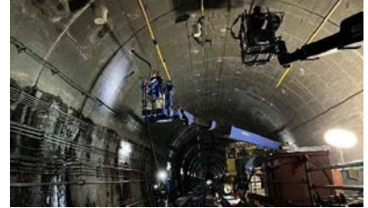
大規模改修工事
