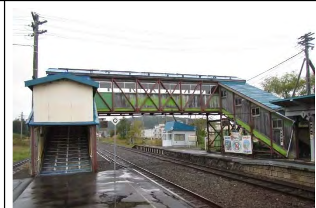
軟弱地盤上の乗換跨線橋
