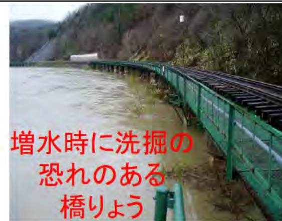
(例: 宗谷線 糠南・雄信内間 問平陸橋)
