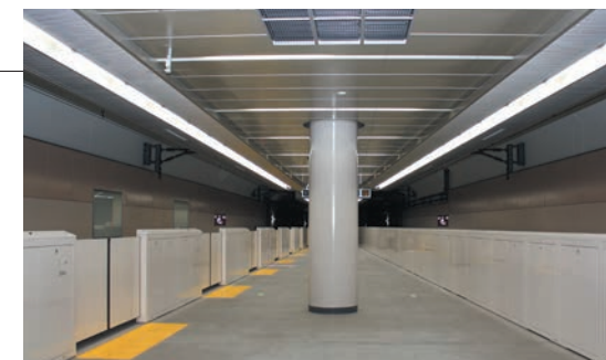
ホーム延伸工事の実施事例(2012年度 南流山駅)
