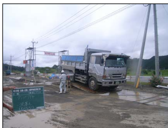
② 高圧洗浄によるタイヤの洗浄
