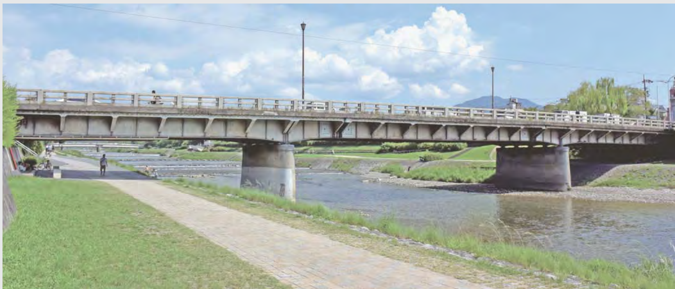
現在の二条大橋
