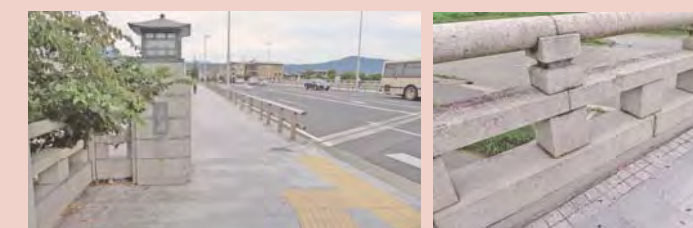
↑嵩上部事例(共に北大路橋)
