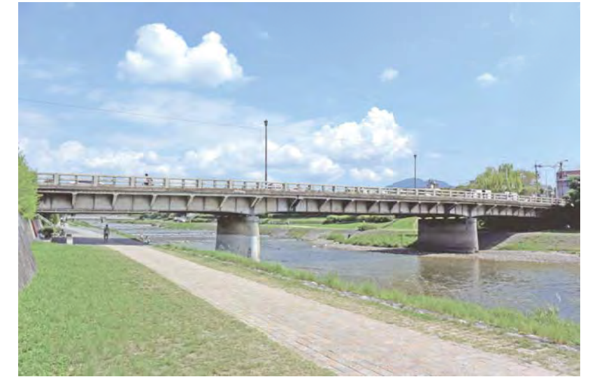
現況の二条大橋
