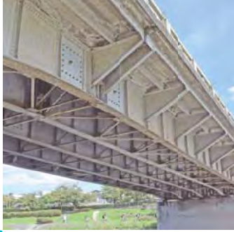
⑤橋桁の塗装
