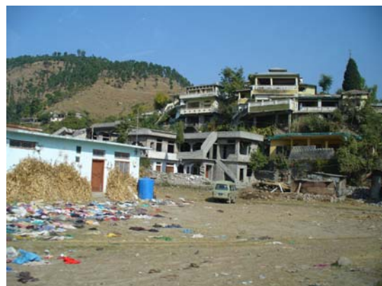
写真 3-10 バラコートの南約 5 km にある鉄筋コンクリート造と思われる建物
