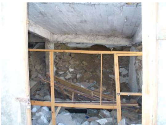
写真 3-9 写真 3-8 の建物の 1 階内部
