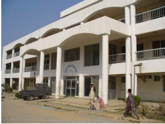
写真 3-11 州立マンセラ病院本館
