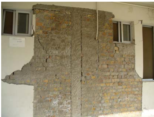
写真 3-13 病院本館1階の柱とレンガ造壁
