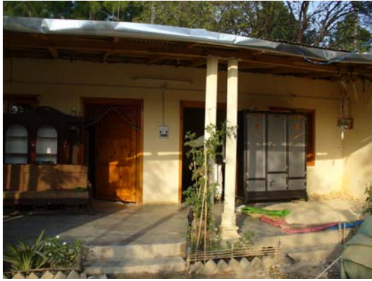
写真 3-25 ブロック造壁構造住宅
