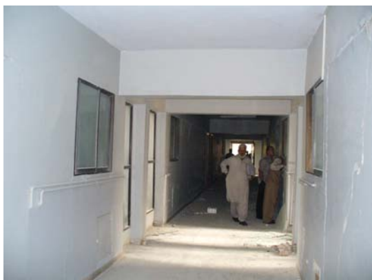
写真 3-33 高層マンション 1 階廊下
