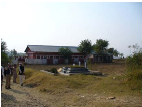
写真 3-23 州立女子小学校 2 棟(左が RC 造、右がブロック造)
