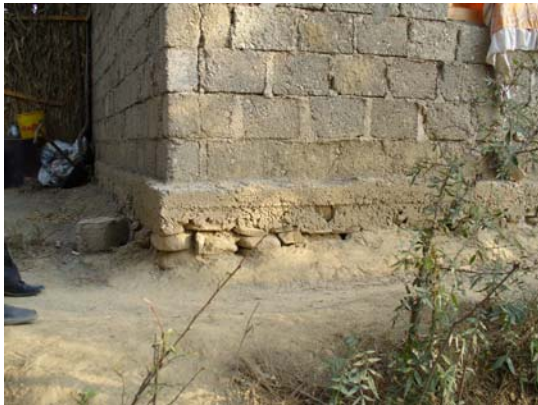
写真 3-27 基礎の割り栗石による地業
