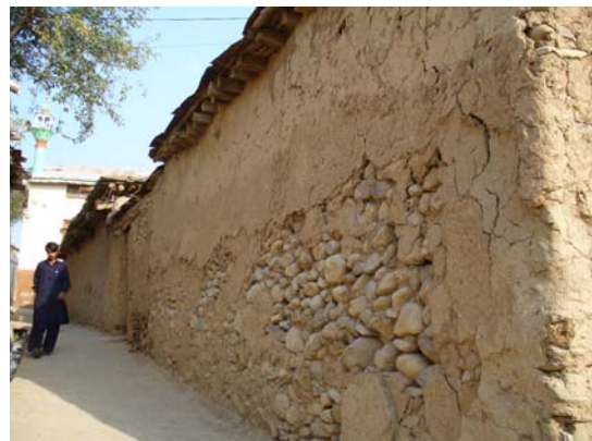
写真 3-20 石造壁住宅左側側面
