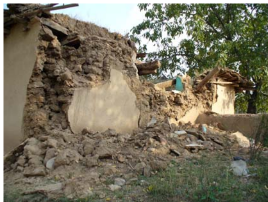
写真 3-22 アドベ造住宅背面
