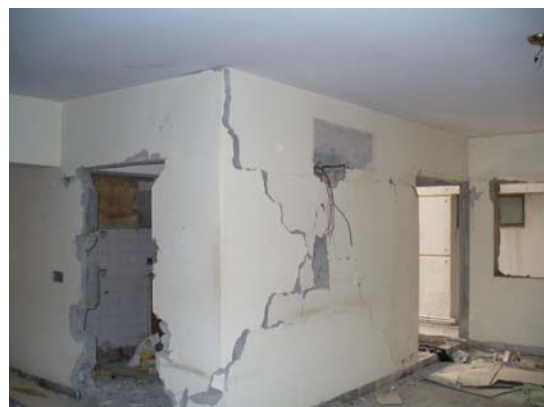
写真 3-34 高層マンション 1 階住居内
