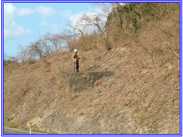
定期巡回（法面確認）
