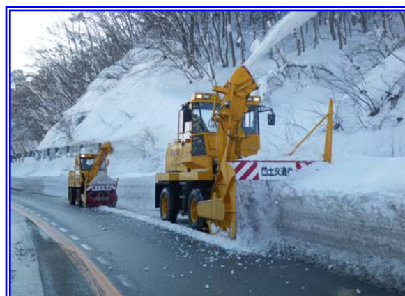
車道除雪（拡幅除雪）
