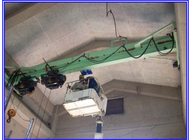
除雪基地設備点検
