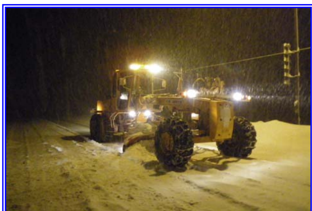
車道除雪（夜間）
