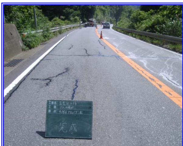
シール材の注入
