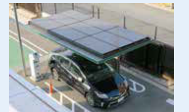
販売店での使用例 *8. Building Energy Management System
