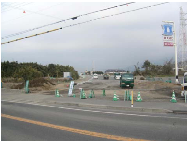
古里地区(起点部)付近 (古里方面から花岡方面を望む) ※現在、側溝敷設、歩道盛土部施工中。 ※今後、車道・歩道舗装施工予定。
