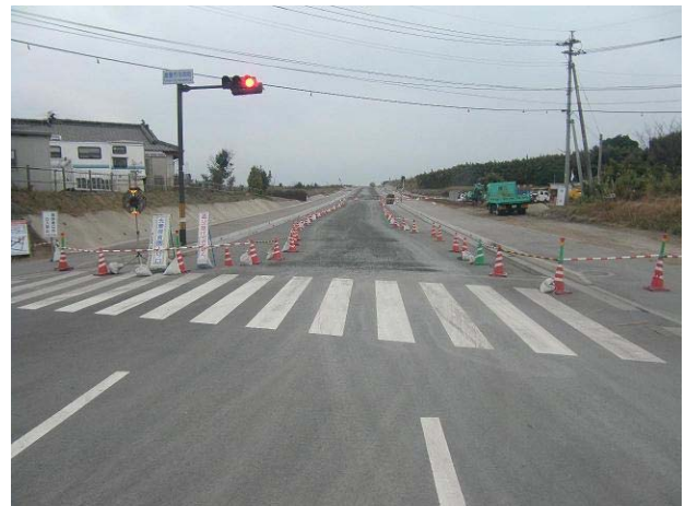
花岡地区(終点部)付近 (花岡方面から古里方面を望む) ※現在、歩道路盤施工中。 ※今後、車道・歩道舗装施工予定。
