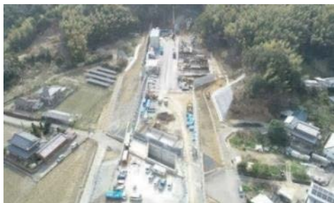
図-7 試行現場全景 (トンネル工事盛土)
