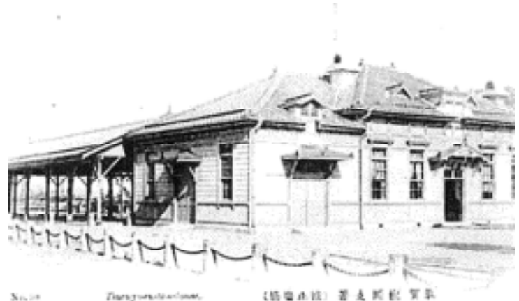
写真4-3 新築間もない頃の敦賀税関支署 (写真 4-2・3 共 鈴置コレクション・井上脩氏提供)
