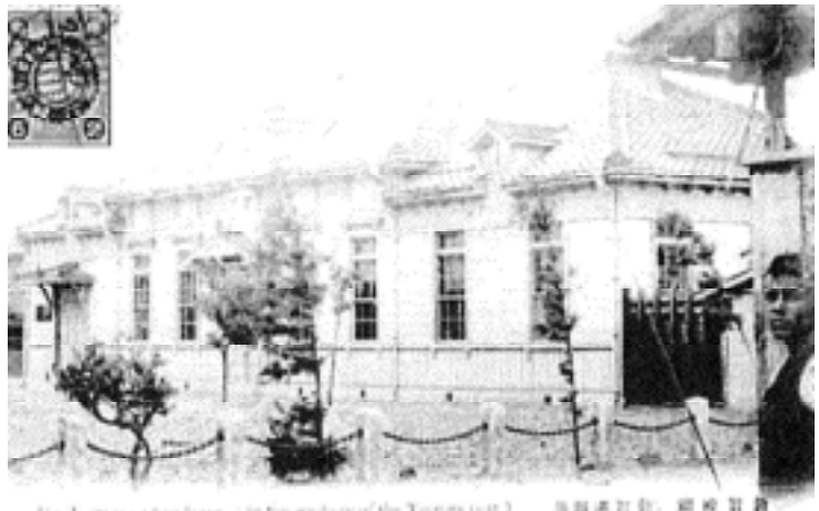
写真4-2 新築間もない頃の敦賀税関支署
