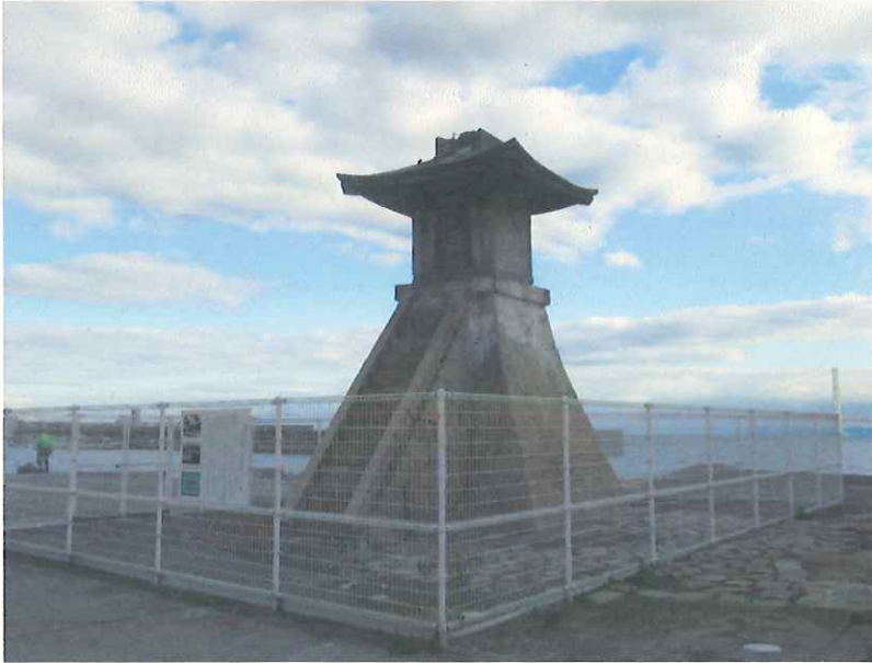
旧波門崎燈籠堂北西から全景
