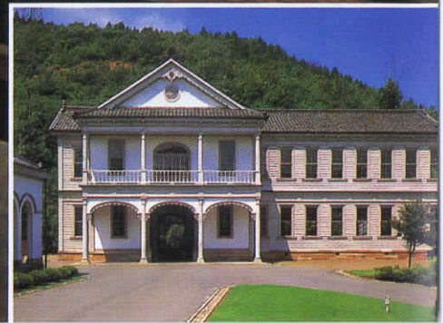
はたして幾人の教師が文字を記し、 どれだけのつづらな瞳が見つめ続けてきたことが…… 愛知県、明治村に保存される 旧三重県尋常師範学校・蔵持小学校と その教室。建設年代は明治21年(1888)。
