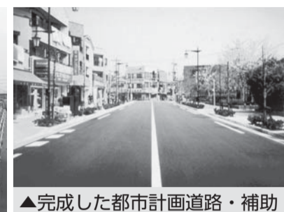
▲完成した都市計画道路・補助285号線（西瑞江2・3丁目）
