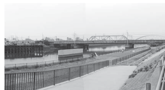
▲工事中の上一色中橋（新中川）
