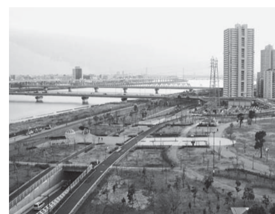
▲スーパー堤防整備にあわせて作られた大島小松川公園
