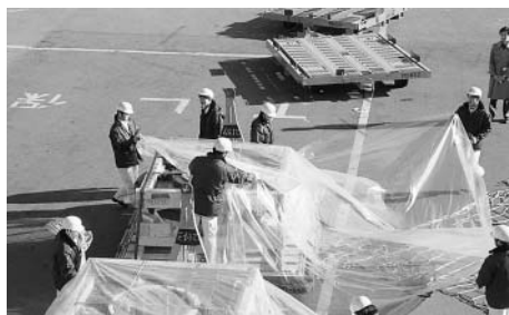
ビニールシートかけ作業
