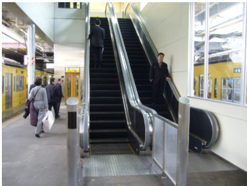
保谷駅のホームに完成したエレベーターとエスカレーター
