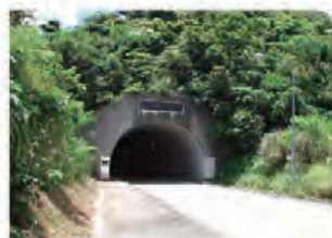
呉我山トンネル
