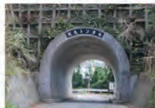
運天トンネル
