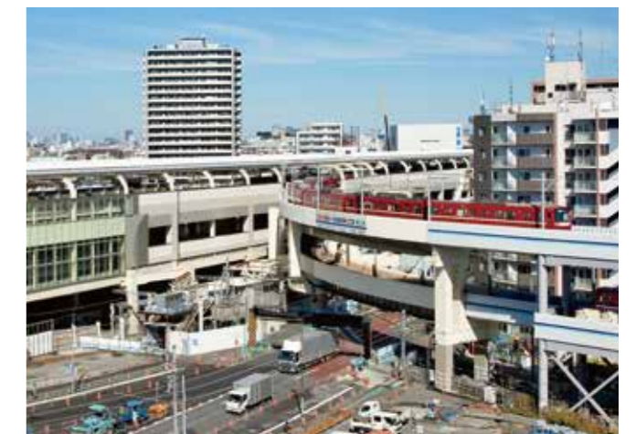
■京急蒲田駅の二層高架橋
