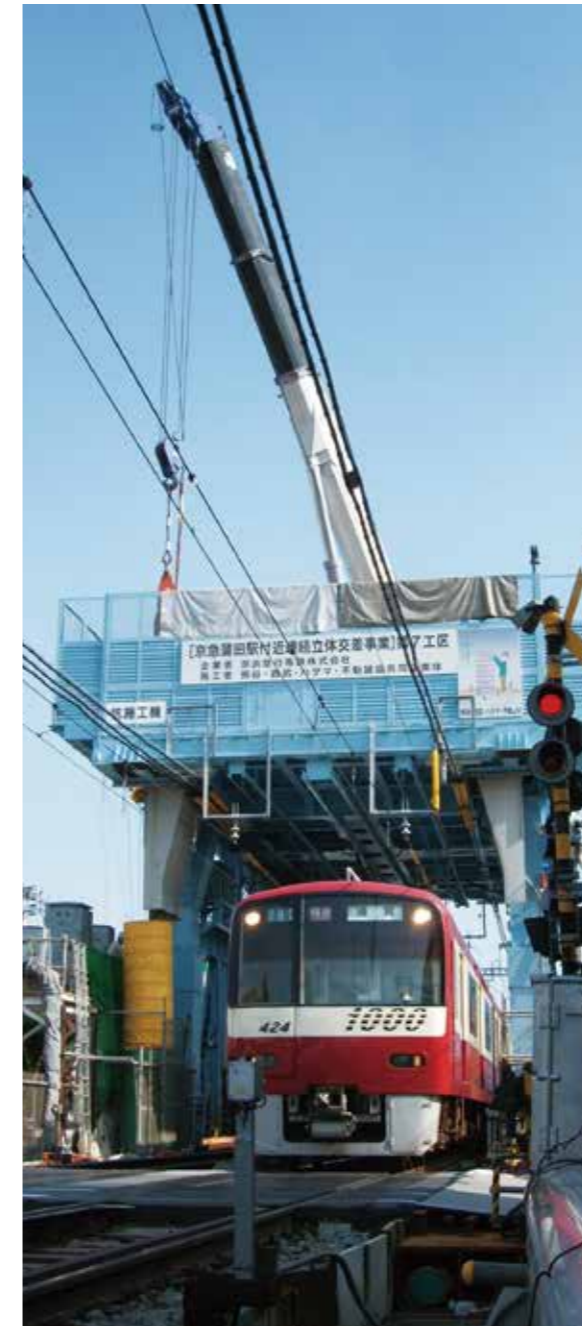
■直接高架施工機による基礎杭施工の様子
