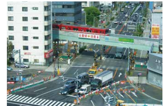
■環状8号線付近上り線の仮高架橋
