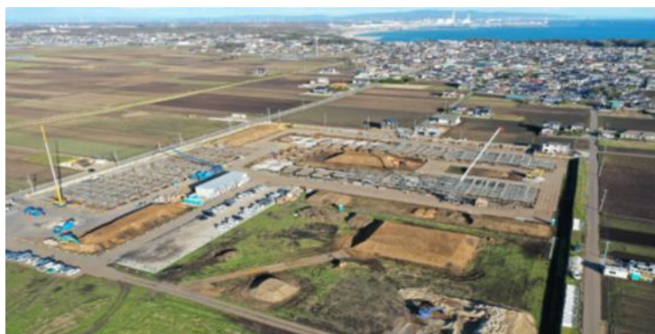
建設現場の様子（令和元年12月撮影）
