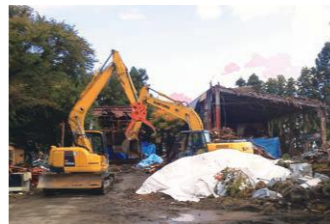
弘前市笹森町東照宮解体の様子
