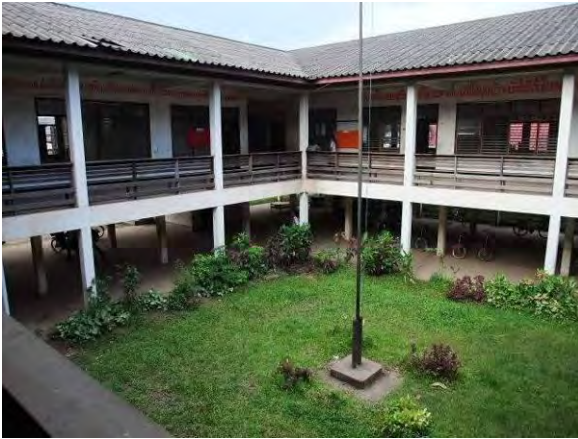
学校敷地は約 2060 平米。豪雨時に約 3 時間で自然排水されるものの約 30 cm 湛水する箇所もあり、校舎はピロティ形式になっている。
