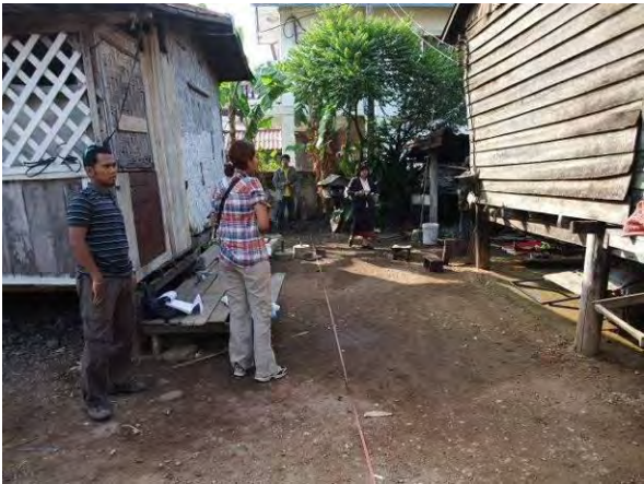
F/SでのDEWATSプラント建設候補地の測量
