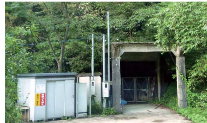
中性子を照射された試料は、ノイズとなる自然放射線が少ない廃鉱のトンネル内に設けられた「極低レベル放射線測定室」で長期間にわたって測定された。トンネル脇のプレハブ小屋は、測定器を冷却するための液化窒素の製造設備
