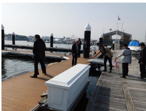
(改修前、改修後の栈橋を視察する委員)
