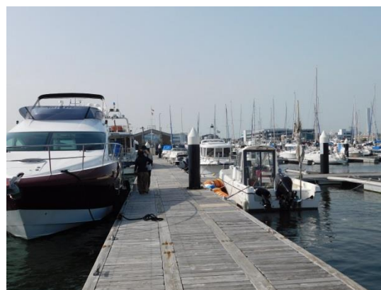
(係留棧橋の一部)
