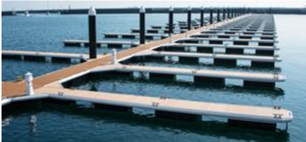
(改修を行った横浜ベイサイドマリーナの浮棧橋)
