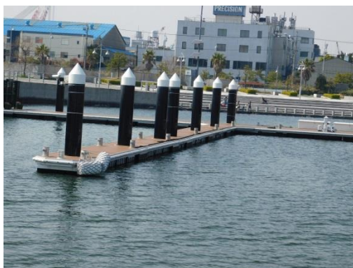
(栈橋を固定する杭)
