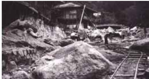
写真-1 人力による工事風景
