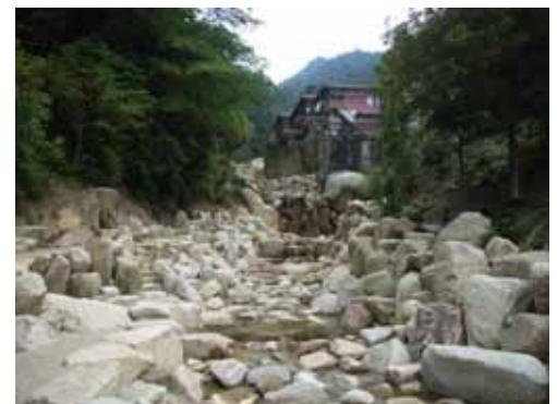
写真 - 4 白糸川の溪流保全工
