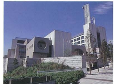
都筑区総合庁舎
