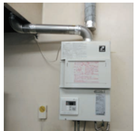
写真7-7 フード対応型ガス給湯器
