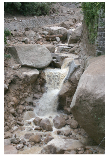
平成17年の台風14号で発生した白糸川の土石流災害 (「中国地方地域づくりと土木のあゆみ」より)
