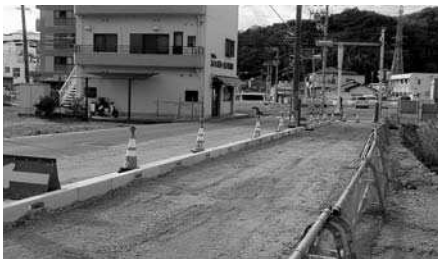
▲拡幅工事が進む旧県病横の市道下加茂線
