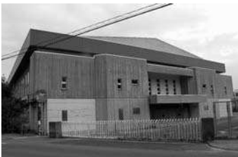
▲備蓄倉庫として利用している洲本市旧スポーツセンター体育館
