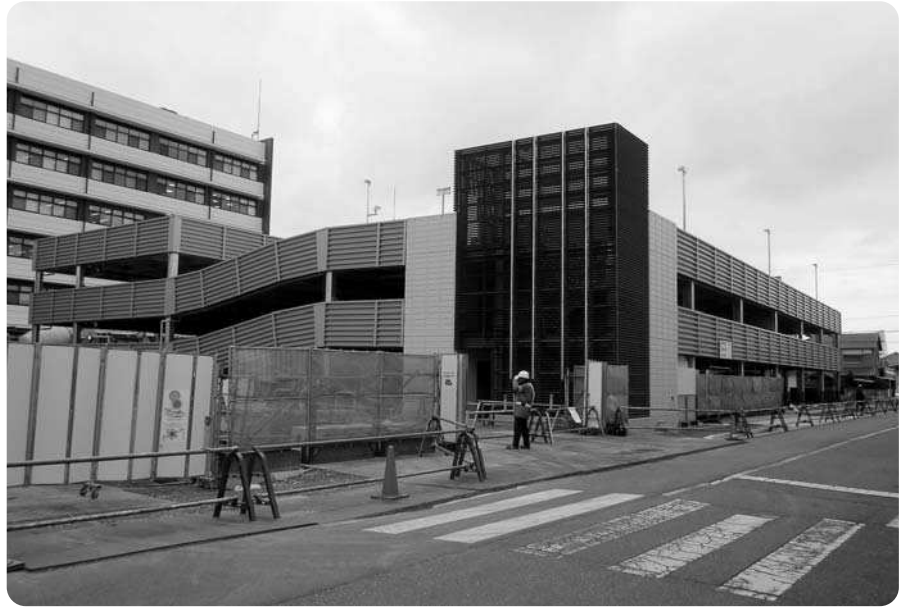
▲市役所へ用事で来られた方の駐車は無料とする予定の立体駐車場
