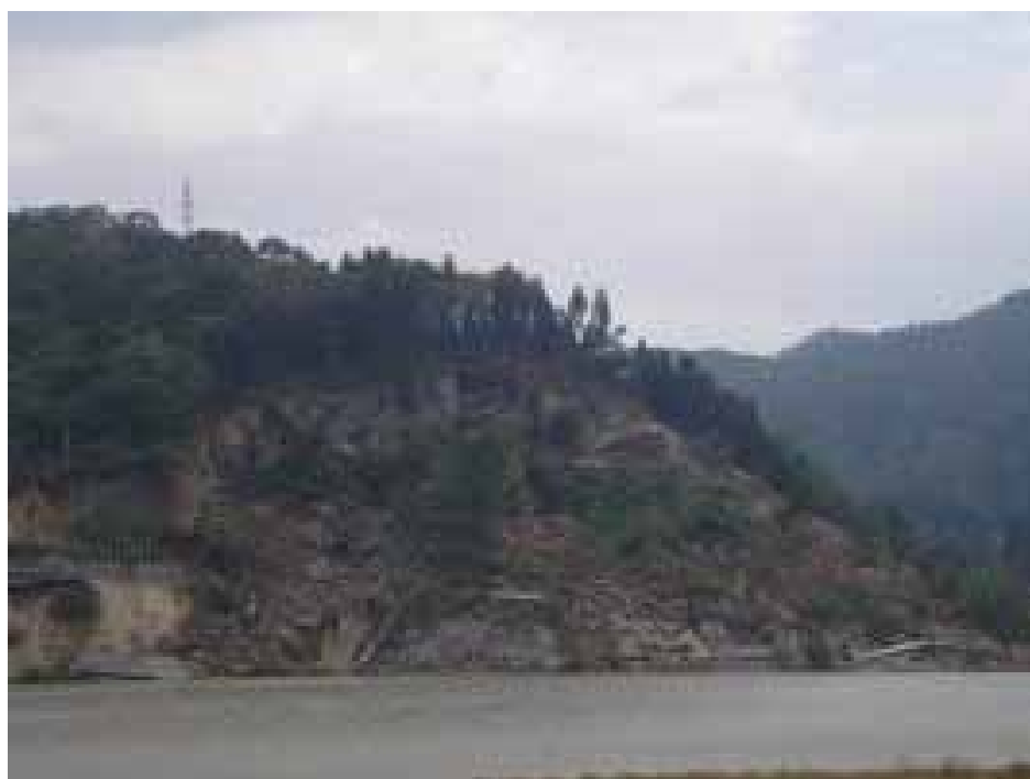
写真 - 2.17 斜面崩壊(1) (2004年10月25日)
