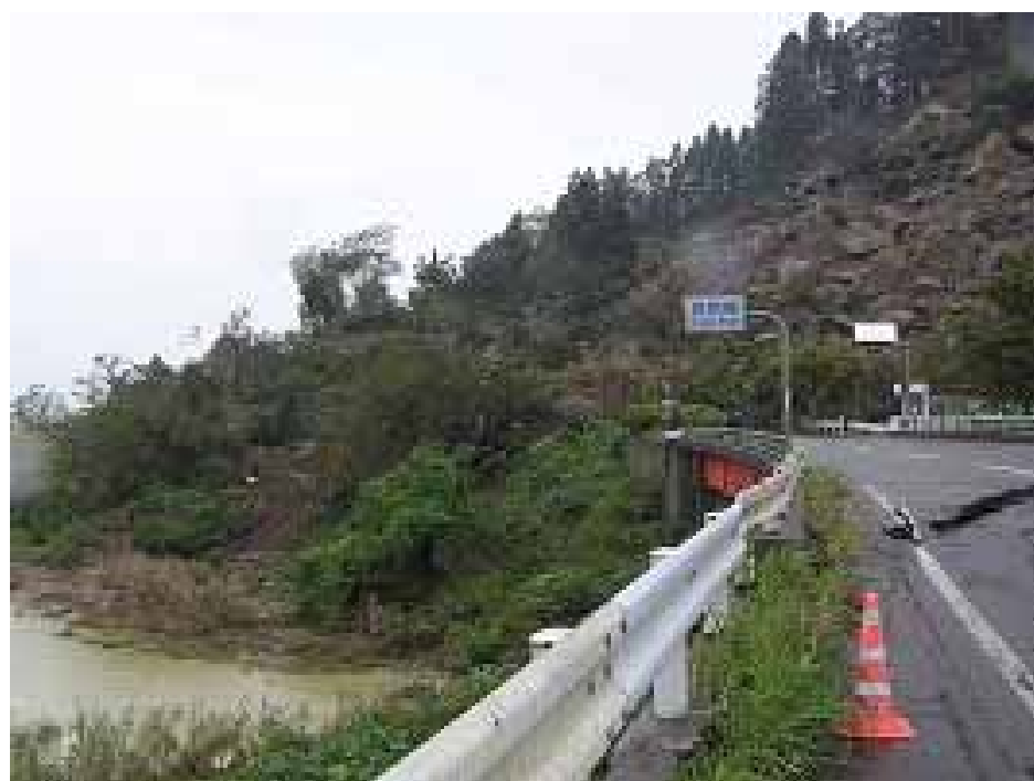
写真 - 2.18 斜面崩壊(2) (2004年10月25日)
