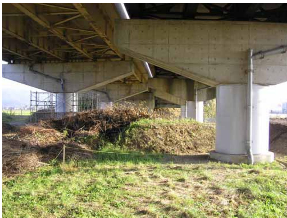
写真 - 2.112 復旧状況(2) ( 2004 年 11 月 7 日 )
