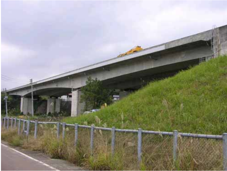
写真 - 2.87 橋梁全景 ( 2004 年 10 月 25 日 )
