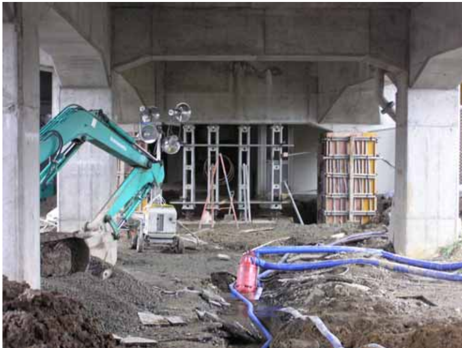
写真 - 2.64 復旧状況(2) (2004年11月6日)
