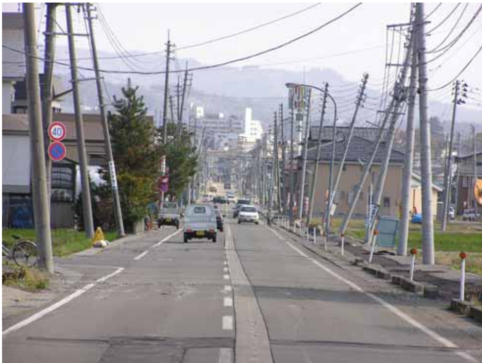
写真 - 2.32 周辺部の電柱の傾斜（2004年11月7日）
