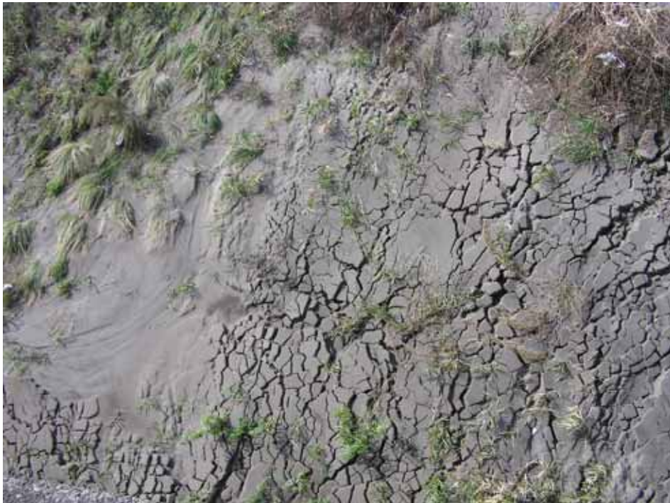
写真 - 2.28 小千谷大橋 河川内の液状化 (2004年11月7日)
