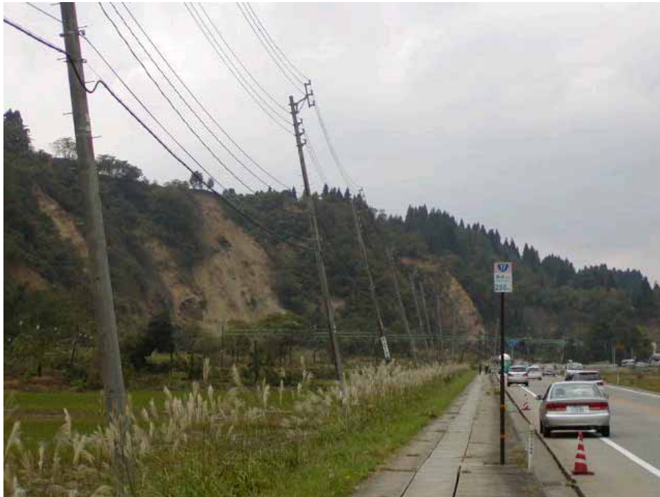
写真 - 2.82 地盤変状(2) (2004 年 10 月 25 日)
