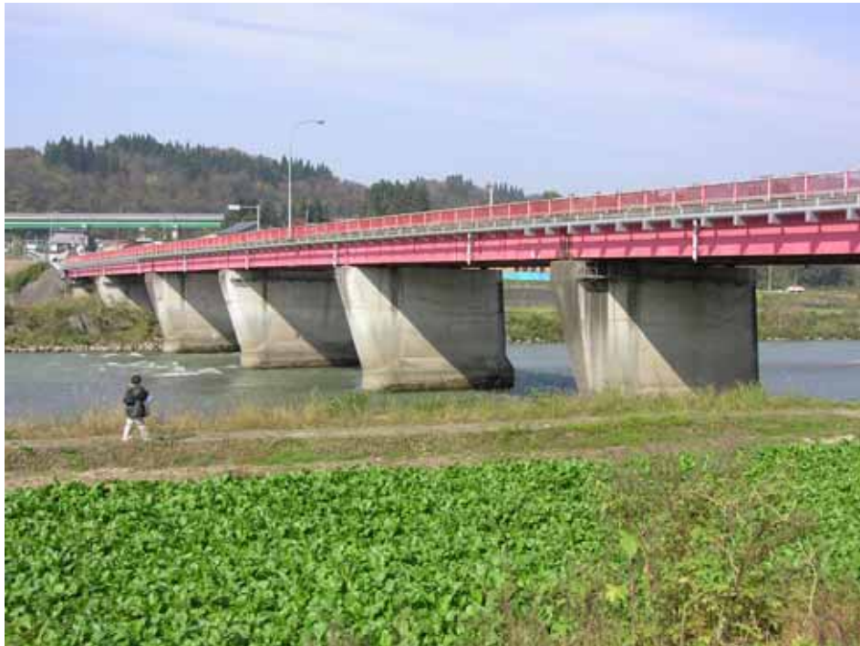
写真 - 2.43 橋梁全景 (2004 年 11 月 6 日)
