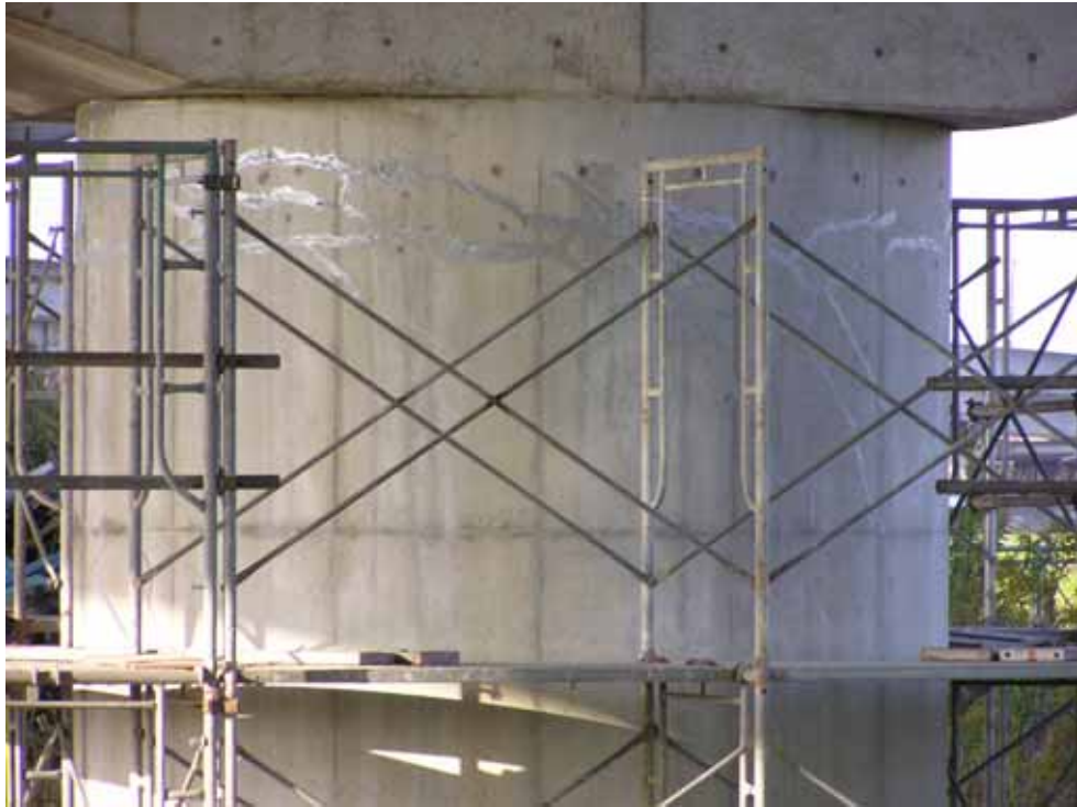
写真 - 2.115 復旧状況(5) (2004年11月7日)
