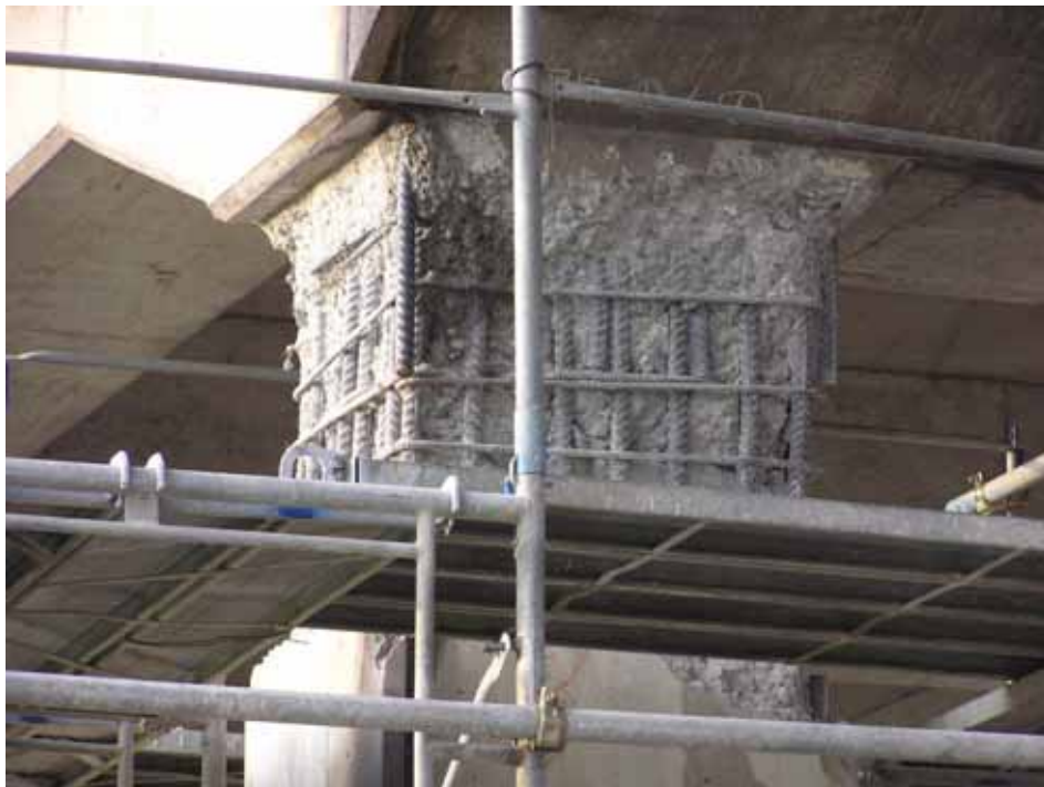
写真 - 2.10 上越新幹線高架橋 復旧状況(2) (2004年11月7日)
