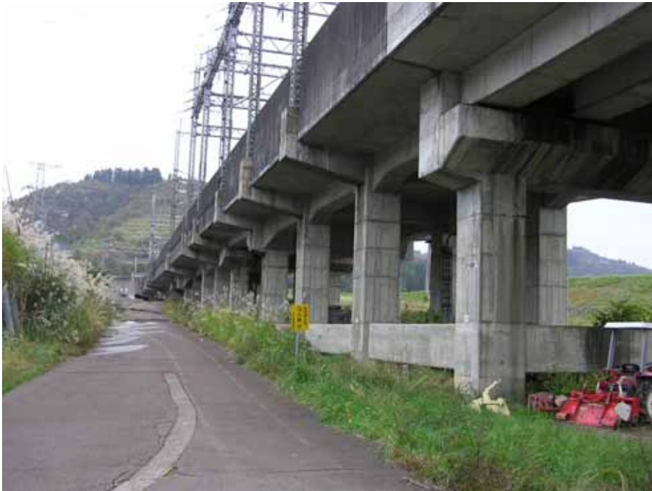
写真 - 2.47 高架橋全景 (2004年10月25日)
