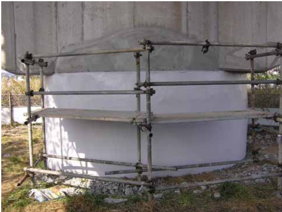
写真 - 2.26 小千谷大橋 復旧状況(1) (2004年11月7日)
