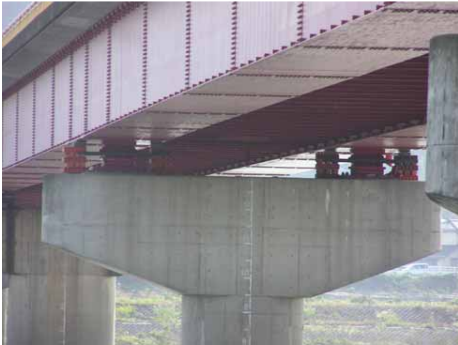
写真 - 2.25 小千谷大橋 (2004年11月7日)
