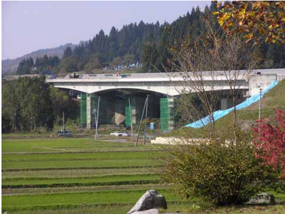
写真 - 2.95 復旧状況(1) (2004年11月6日)
