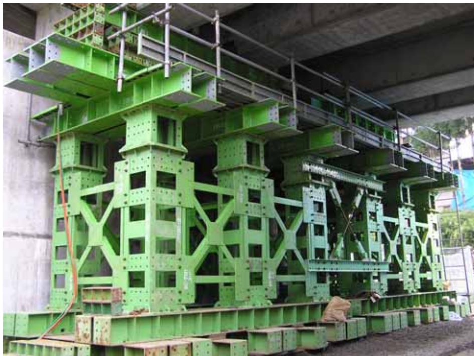
写真 - 2.66 復旧状況(4) (2004年11月6日)
