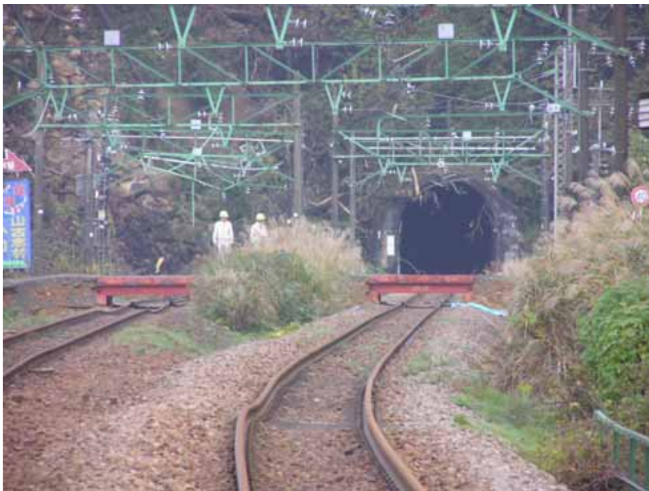
写真 - 2.24 榎トンネルの被災状況(4) (2004年11月7日)
