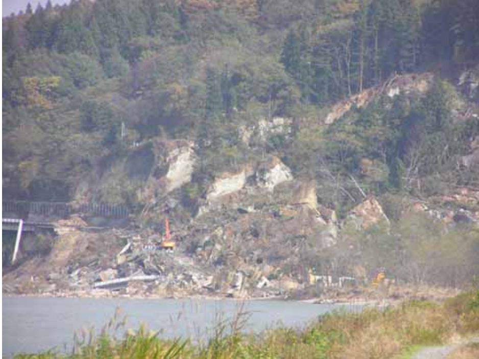
写真 - 2.19 斜面崩壊(3) (2004年11月7日)
