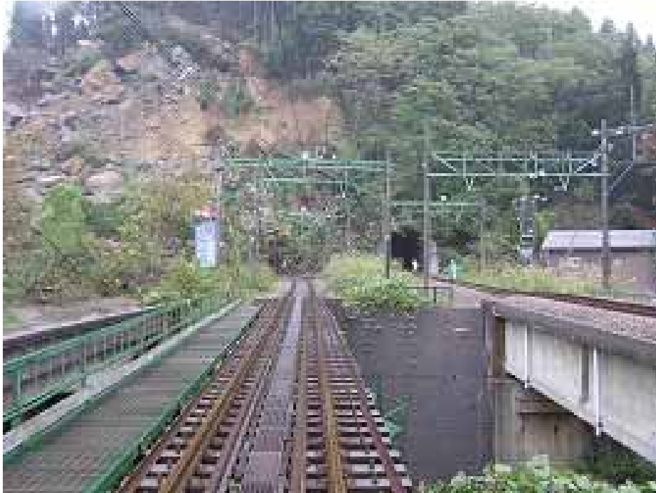
写真 - 2.21 榎トンネルの被災状況(1) (2004年10月25日)
