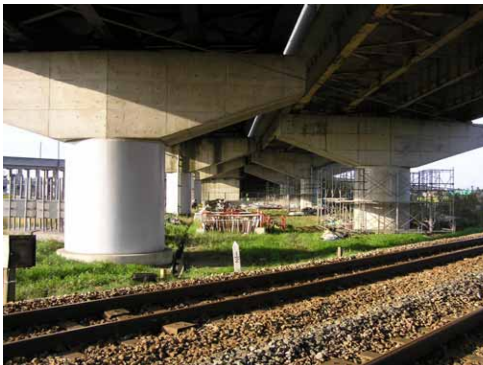
写真 - 2.111 復旧状況(1) ( 2004 年 11 月 7 日 )
