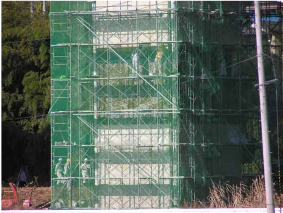
写真 - 2.96 復旧状況(2) (2004年11月6日)
