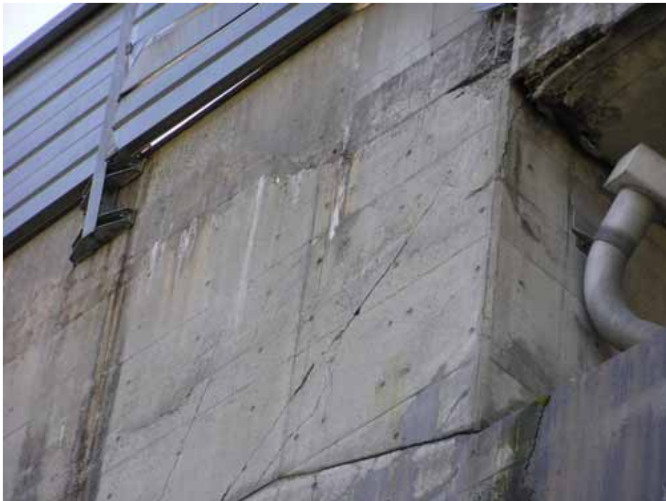
写真 - 2.98 復旧状況(4) (2004年11月6日)
