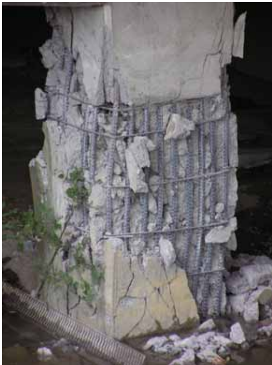
写真 - 2.52 高架橋の損傷(2) (2004年10月25日)
