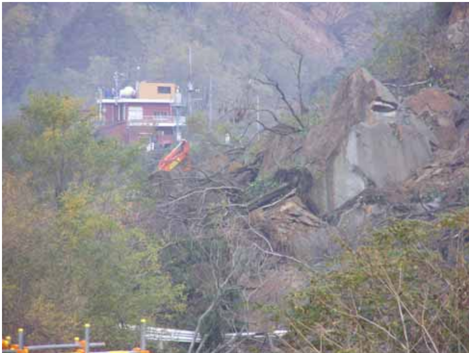
写真 - 2.20 斜面崩壊(4) (2004年11月7日)
