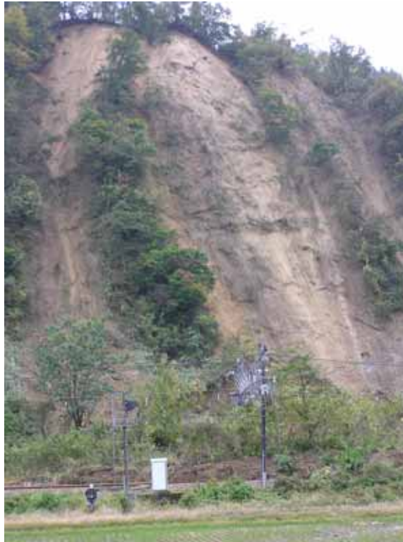
写真 - 2.83 斜面崩壊(1) (2004年10月25日)
