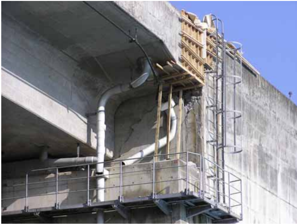
写真 - 2.97 復旧状況(3) (2004年11月6日)
