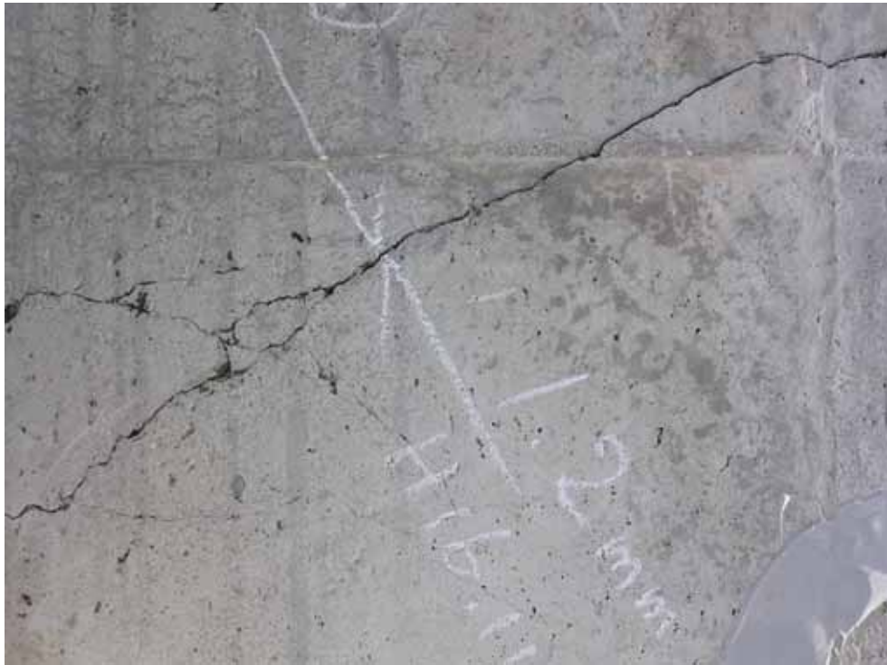
写真 - 2.116 復旧状況(6) (2004年11月7日)
