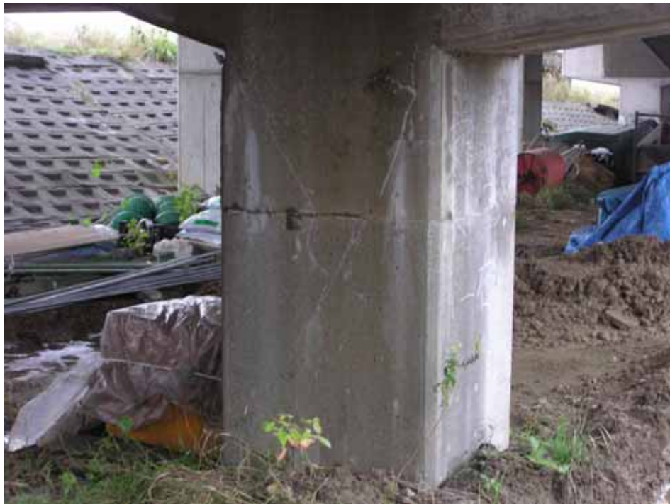
写真 - 2.65 復旧状況(3) (2004年11月6日)
