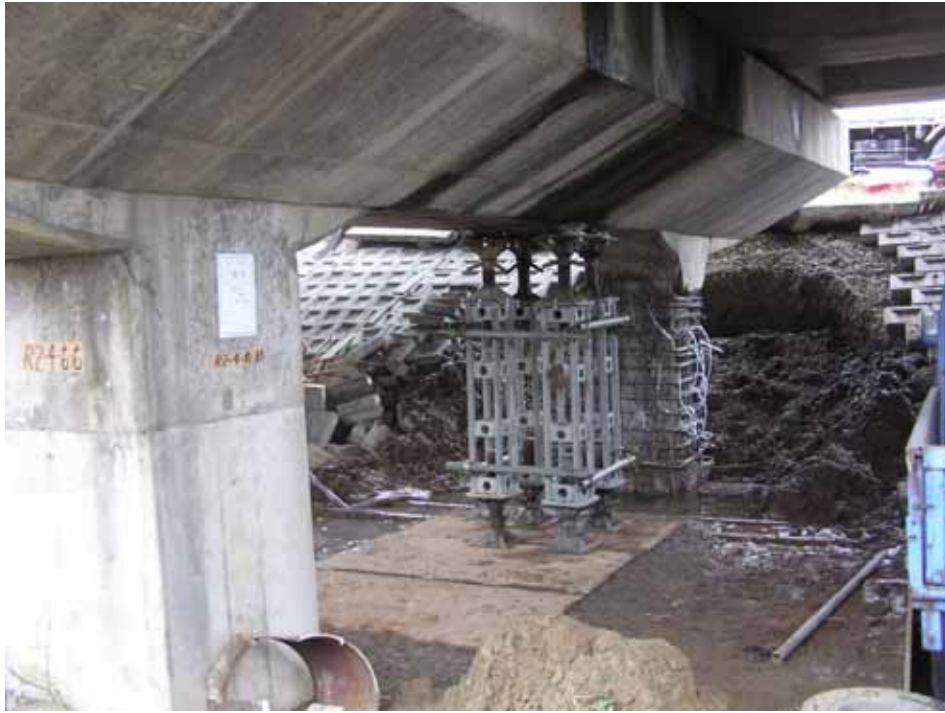
写真 - 2.63 復旧状況(1) (2004年11月6日)
