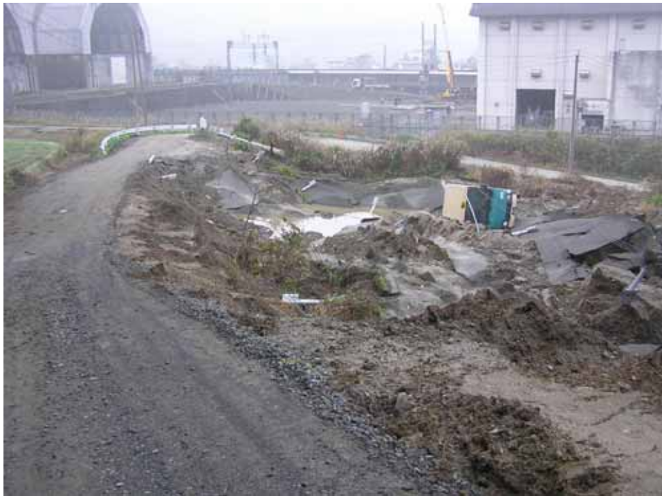
写真 - 2.75 斜面崩壊(3) (2004年11月6日)
