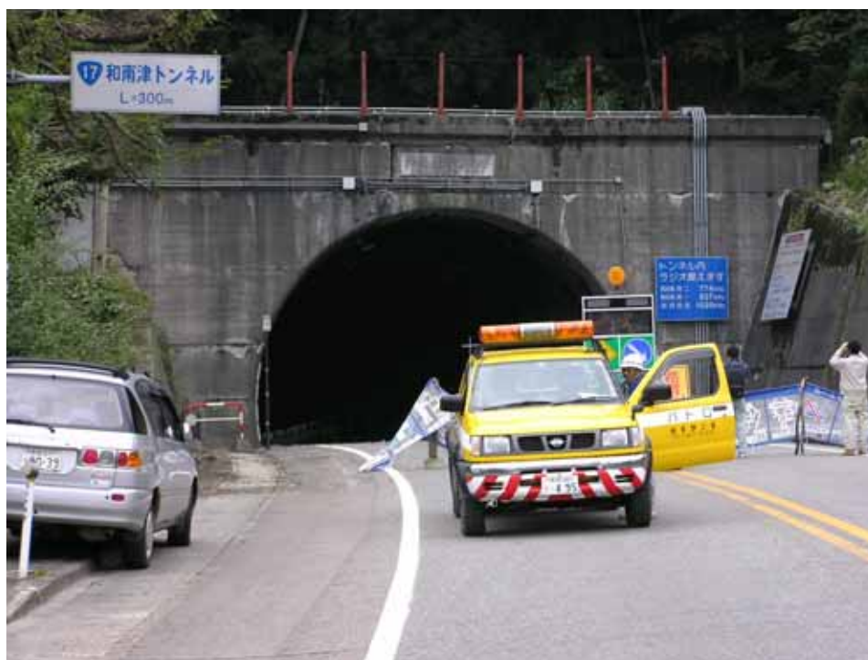
写真 - 2.77 和南津トンネルの被害(1) (2004年10月25日)
