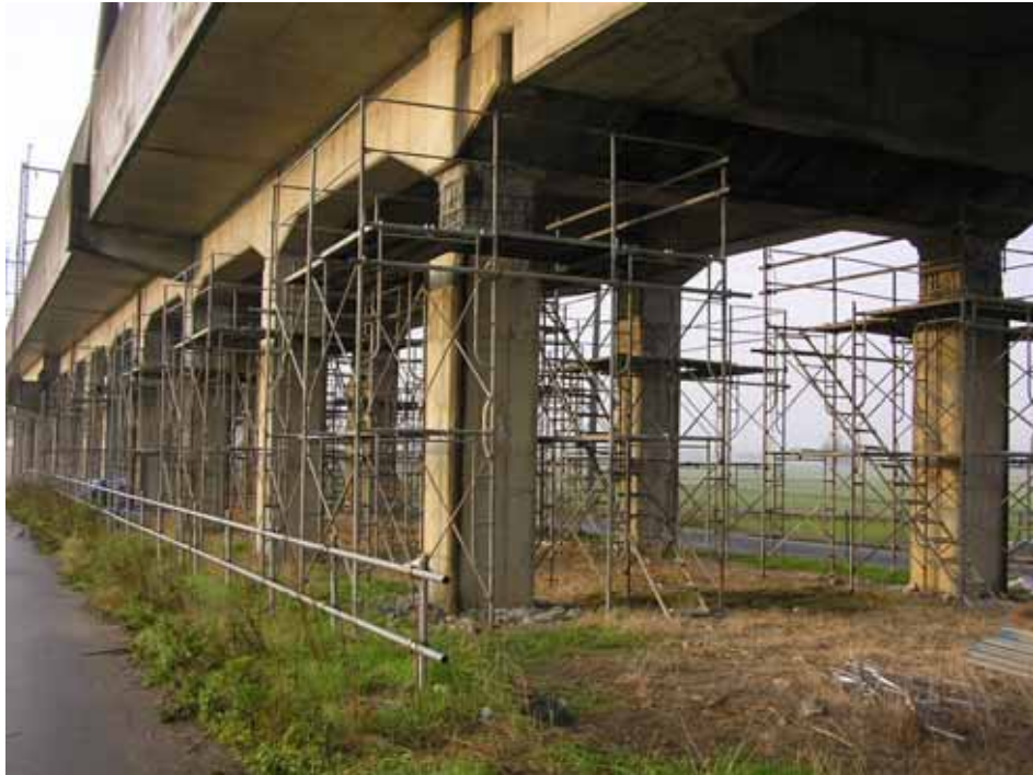
写真 - 2.9 上越新幹線高架橋 復旧状況(1) (2004年11月7日)
