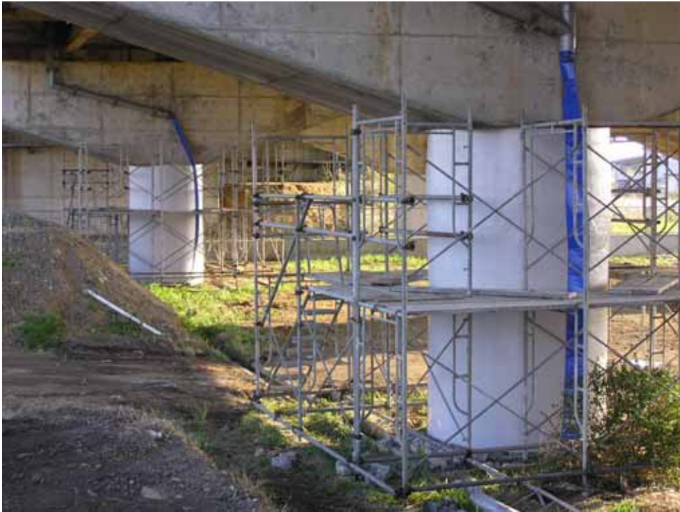
写真 - 2.113 復旧状況(3) (2004年11月7日)
