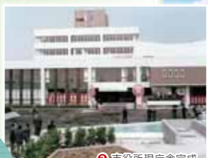
3 市役所現庁舎完成
