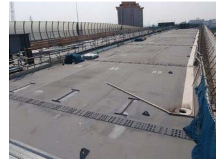
④橋梁上部の状況
