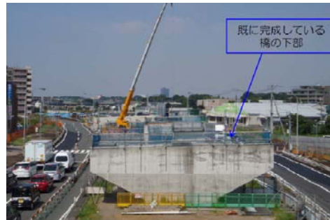
②完成している橋梁下部の状況
