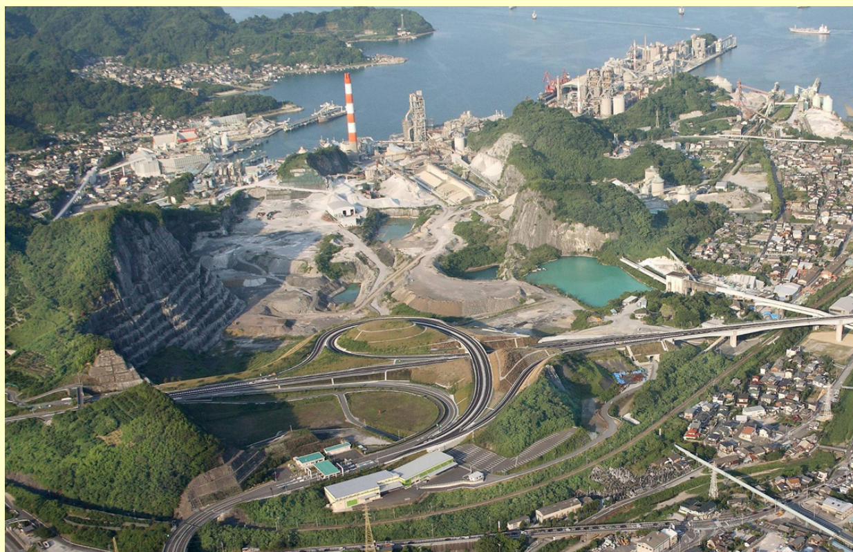
水晶山跡地とその周辺状況
