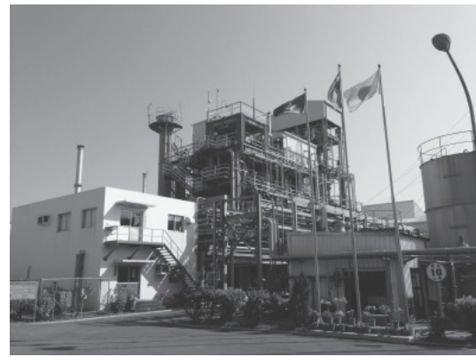
図 5.8 太洋化成社イオン交換樹脂プラント
