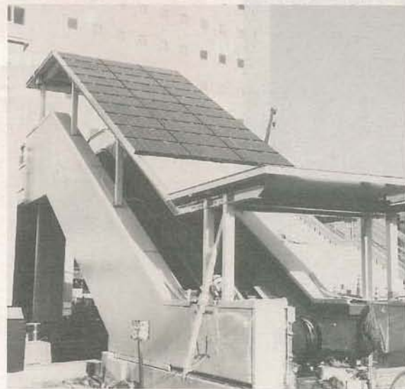
ペDESTリアンデッキ (屋根の上は太陽光発電パネル)
