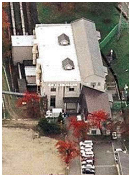
2003年11月撮影 湯沢発電所 外形
