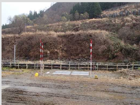
積雪重量計設置状況（全景）
