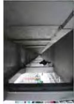
① 補修・補強工事了後
