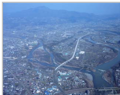
一起点部から終点部を望む
