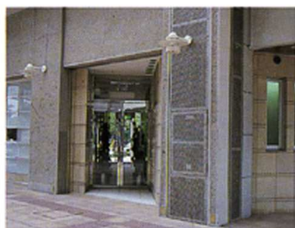
設置位置への配慮と、パンチングメタルによる遮蔽 (神奈川・横浜)
