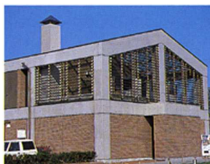
屋根と一体化したルーバーによる遮蔽 (神奈川・横浜)
