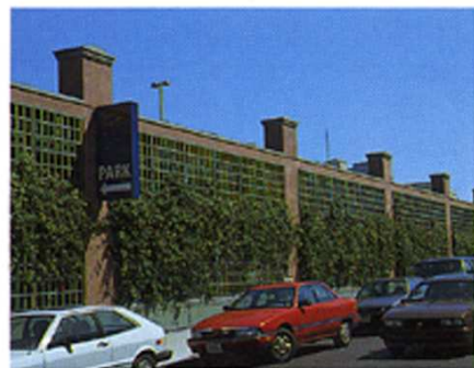
立体駐車場壁面の緑化 (アメリカ・サンフランシスコ)
