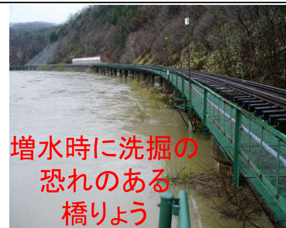
(例: 宗谷線 糠南・雄信内間 問平陸橋)
