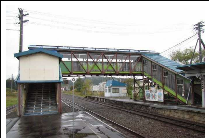
軟弱地盤上の乗換跨線橋
