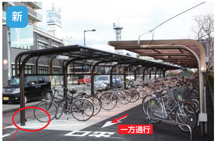
盗難防止用バーを設置
