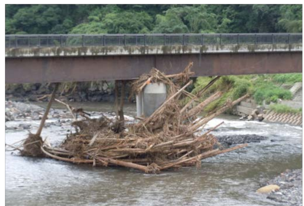
写真 8.4 玉来新橋の橋脚に集積した流木
