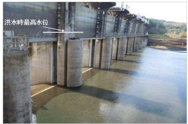
b) 上流側の痕跡水位
