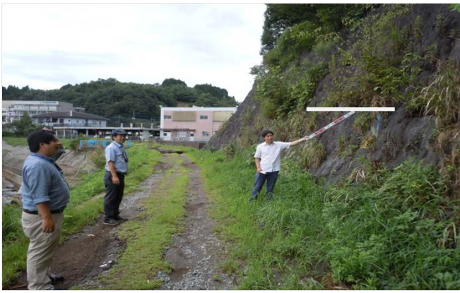
a) 旧河道ショートカット部の堤防における水位痕跡
