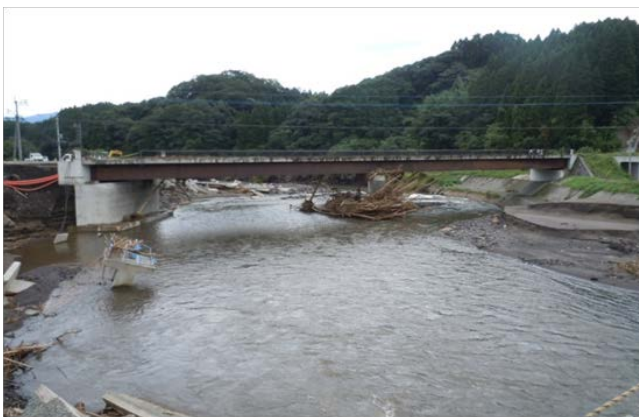
写真 8.4 玉来新橋の橋脚に集積した流木
