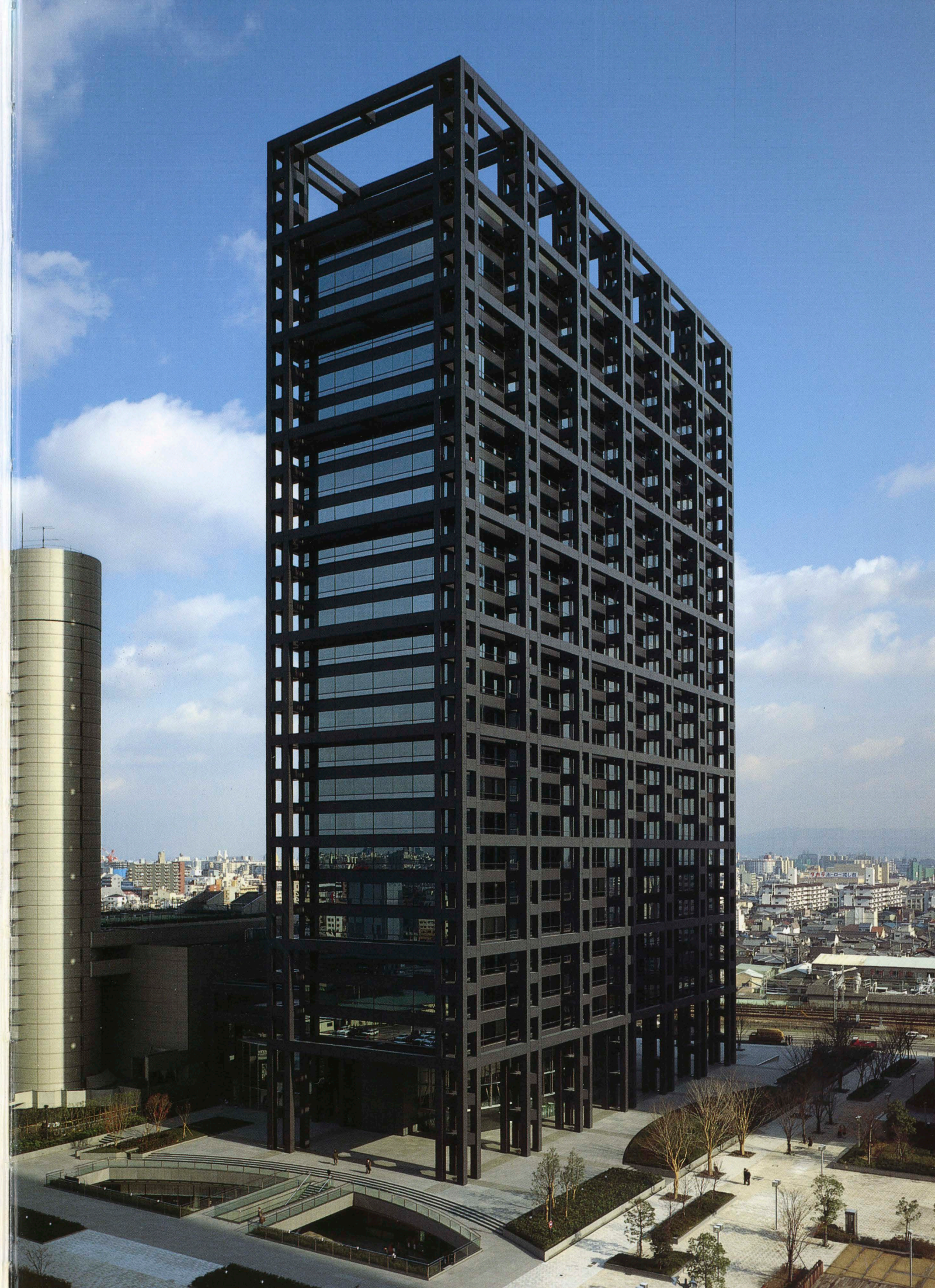
右：西南よりの全景 right: General view
