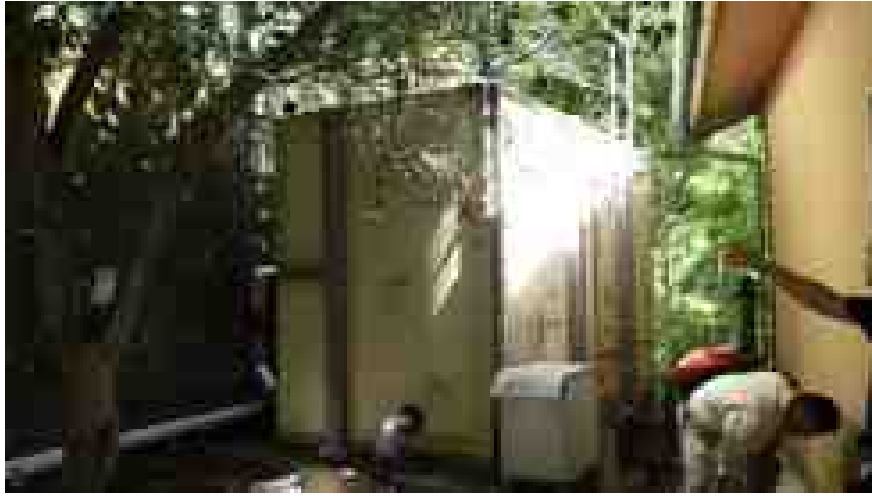
図 6 温泉源泉タンク外観
