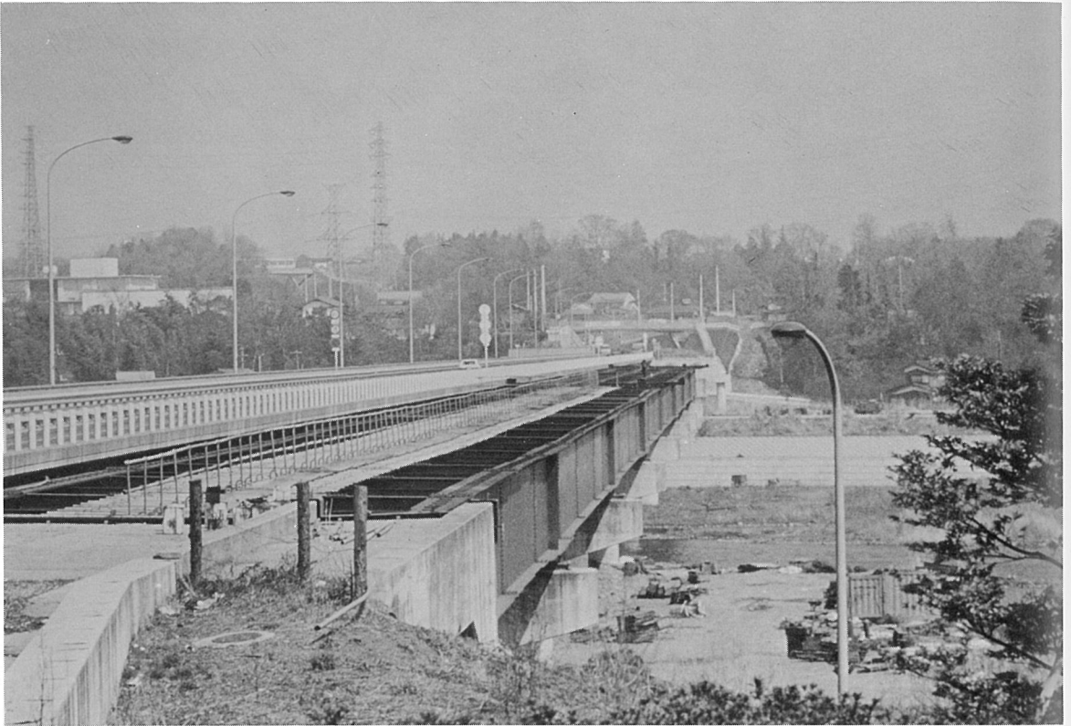
新 昭 和 橋 (連続鉄桁橋)
