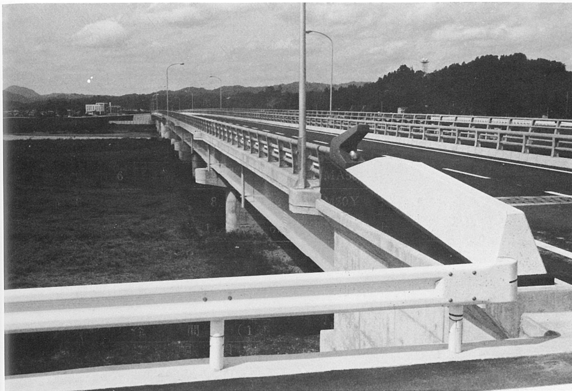
大 上 橋 (連続箱桁橋)
