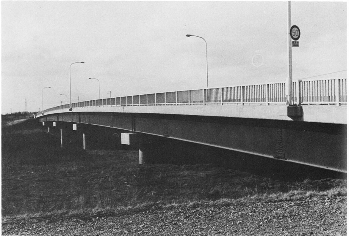
豊川橋 (単純合成鈹桁橋)
