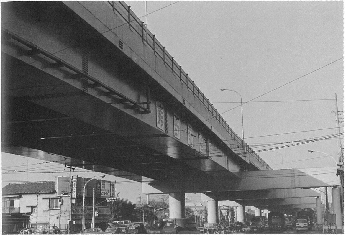
熊野前陸橋 (単純箱桁橋)
