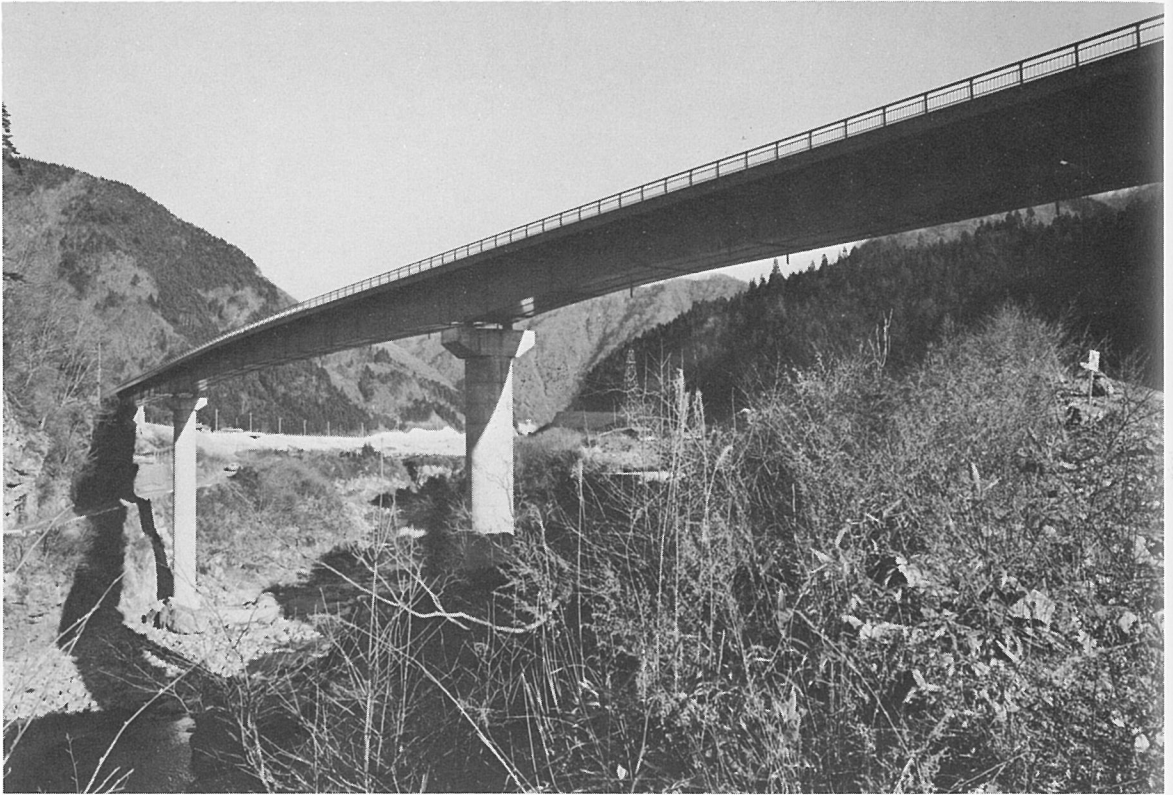
川治ダム 2号橋 (連続箱桁橋)
