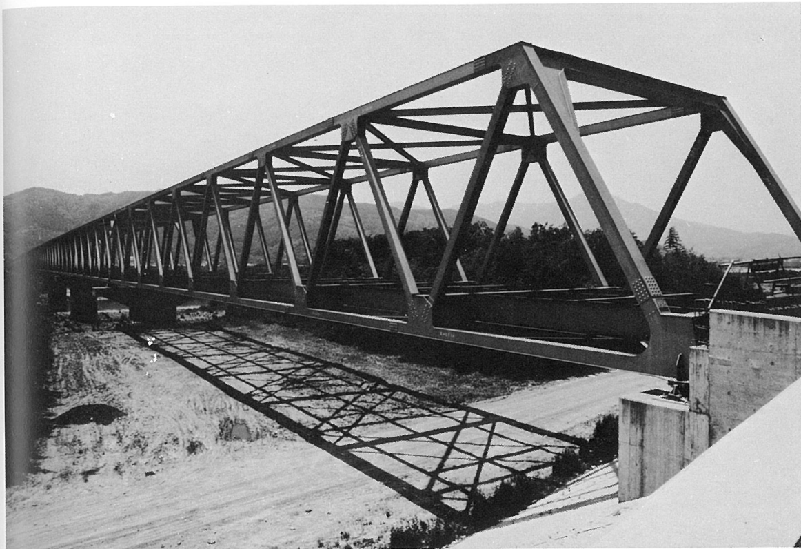
阿波麻植大橋 (連続・ゲルバートラス橋)
