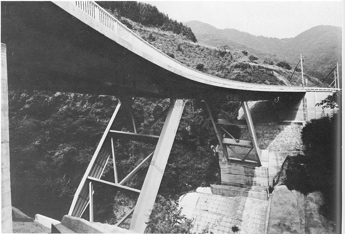
滝壺橋 (ラーメン橋)
