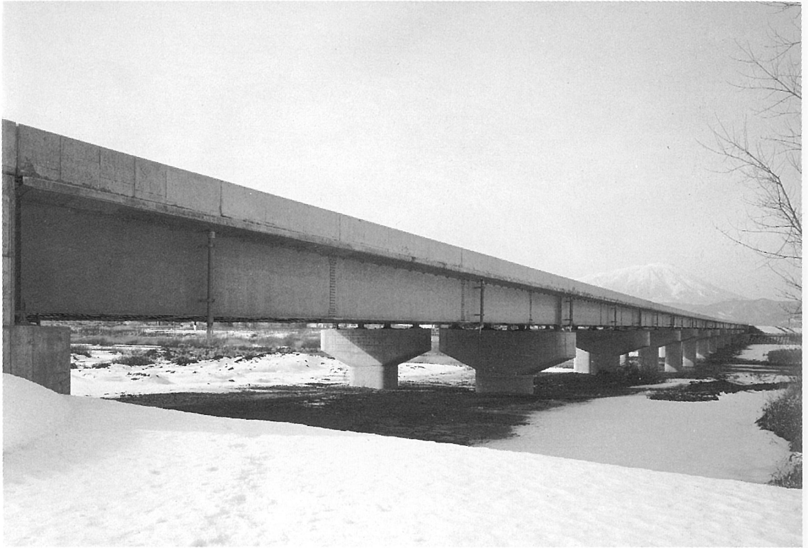
粟石川橋 (連続鉄桁橋)
