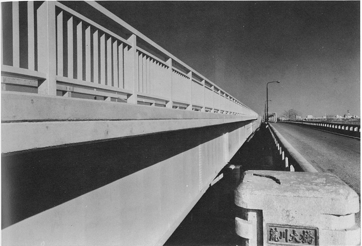
荒川大橋 (連続鈑桁橋)
