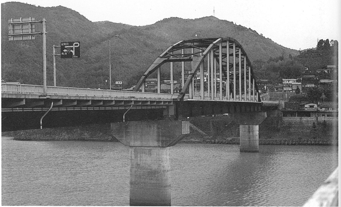
新熊野大橋 (ランガー桁橋)
