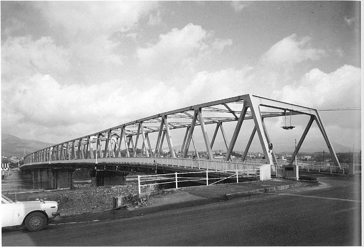
橋 本 橋 (単純トラス橋)
