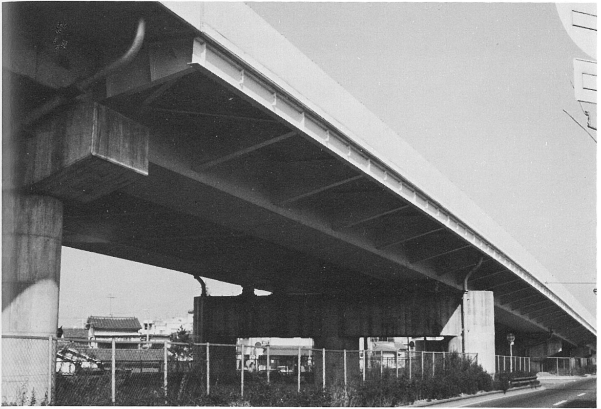
阪 和 高 架 橋 (連続合成箱桁橋)
