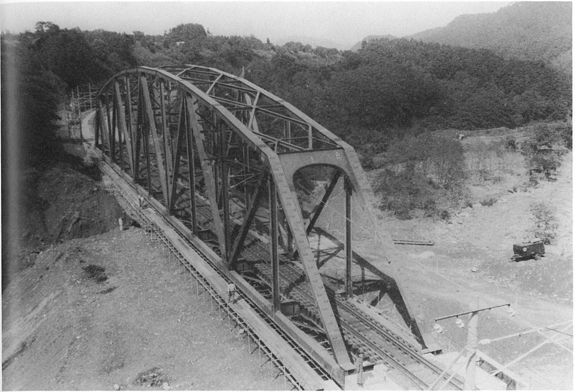
白田切川橋梁 (下路トラス橋)
