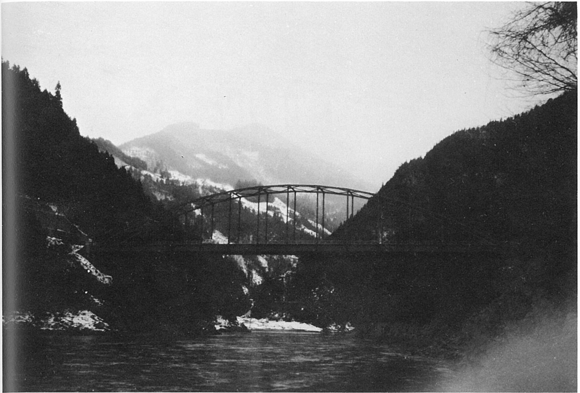
平 神 橋 (ランガー桁橋)
