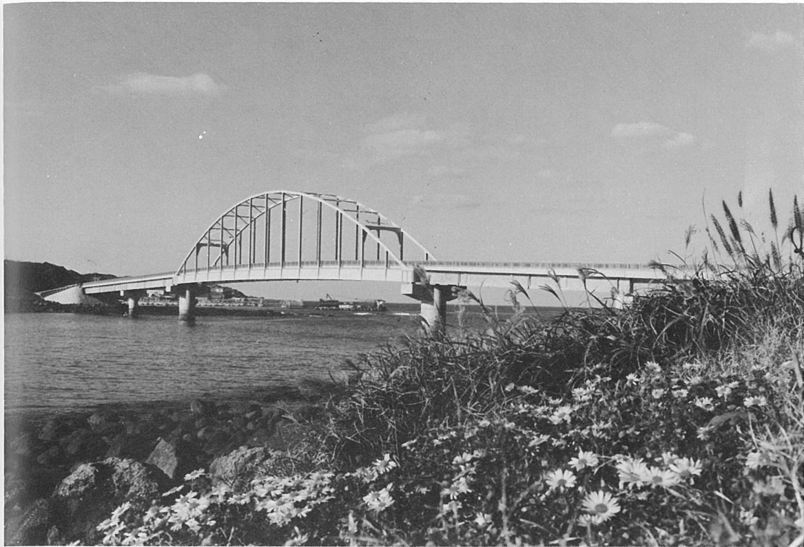
斑 大 橋 (ランガー桁橋)
