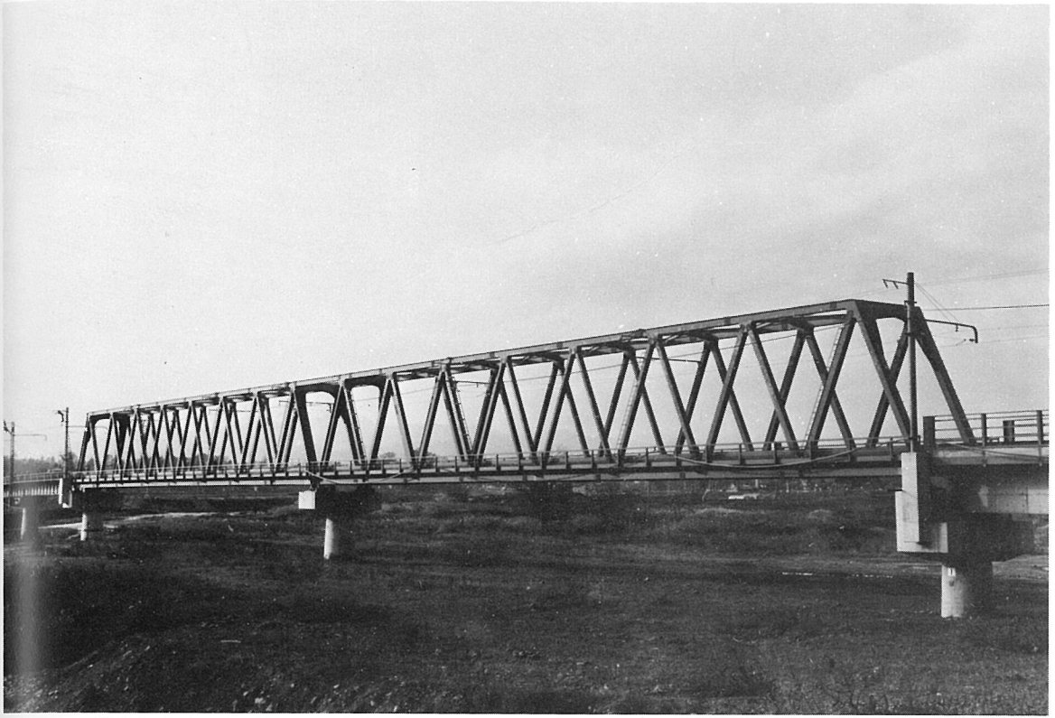
五日市線多摩川橋梁 (下路トラス)
