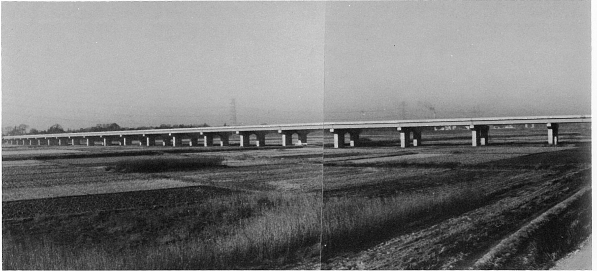
船戸高架橋 (連続鈹桁橋)
