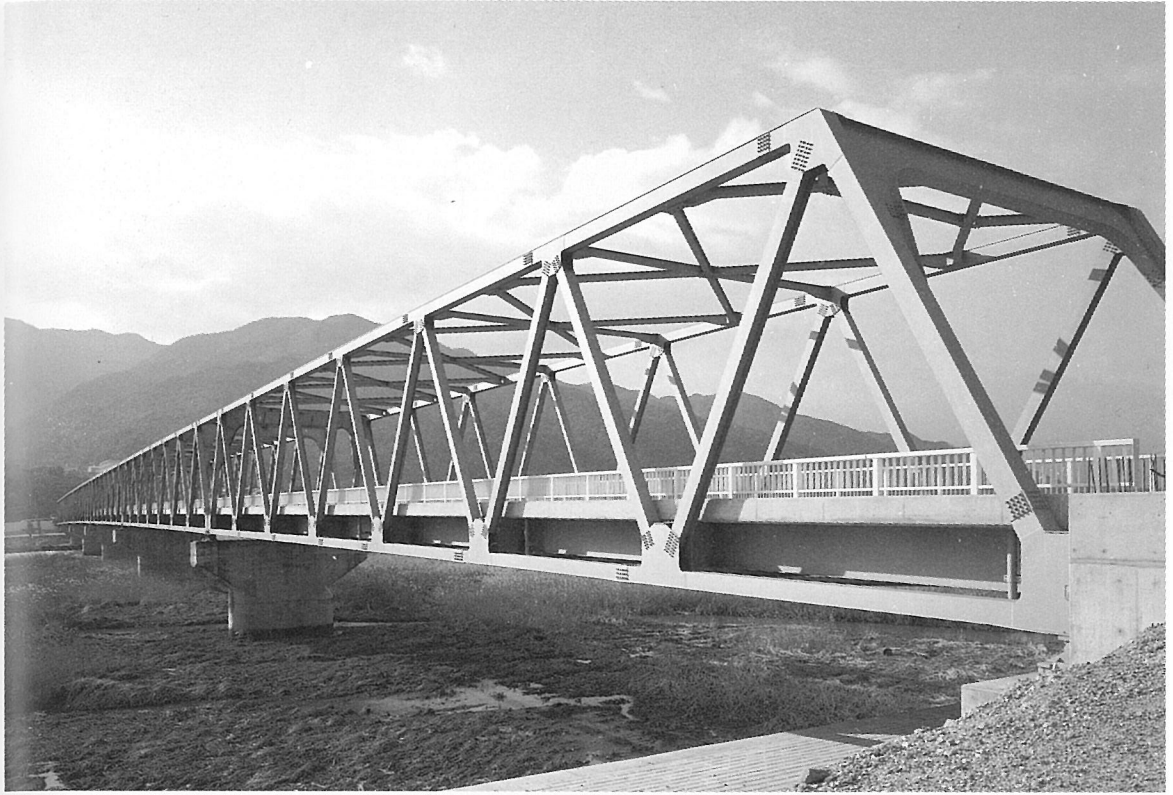
海津橋 (単純トラス橋)
