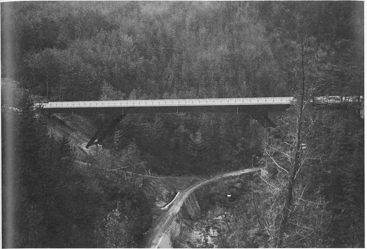
星田川橋 (ラーメン橋)
