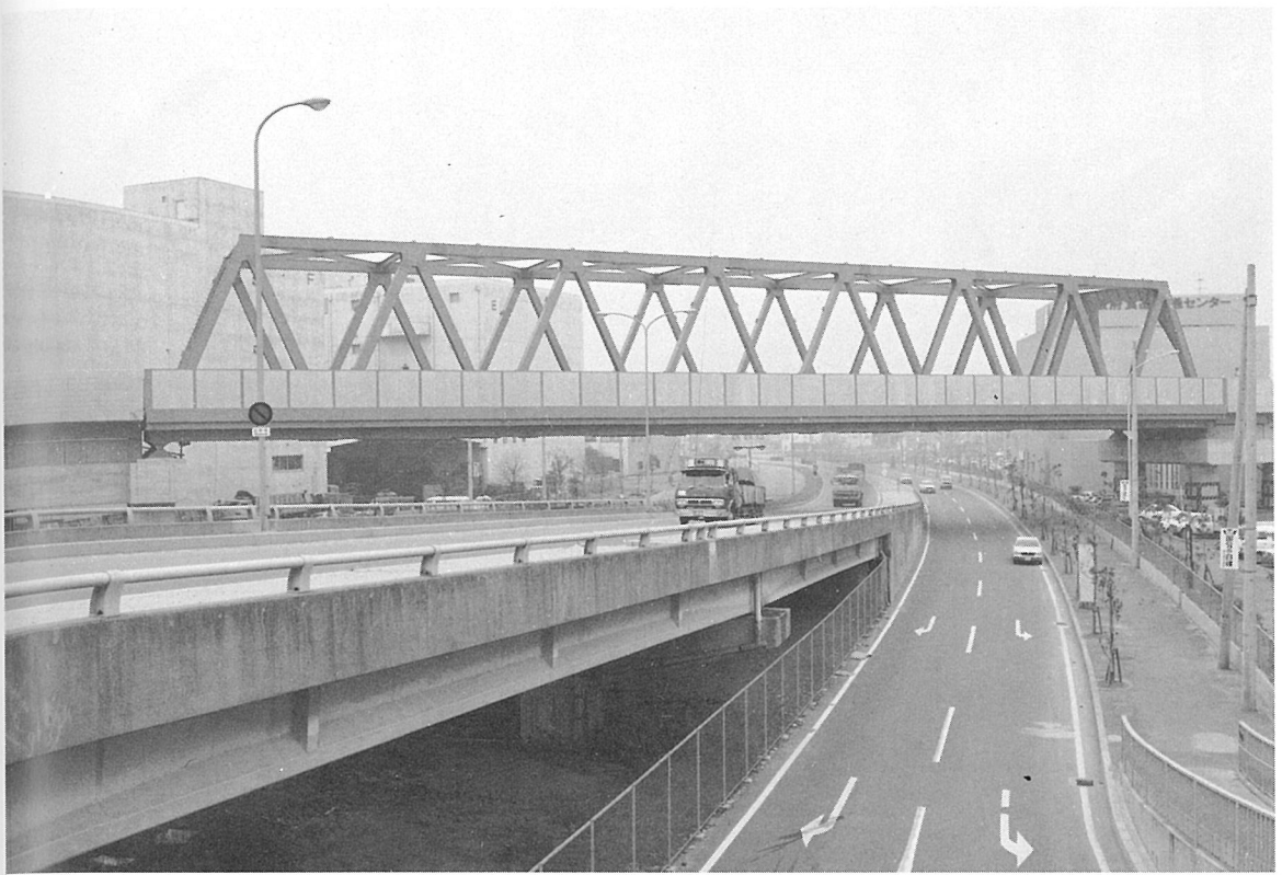
千里丘寝屋川線架道橋 (下路トラス橋)
