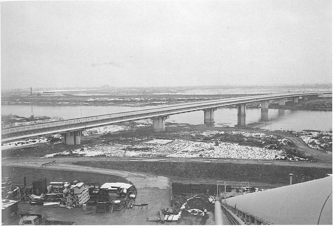
村山橋 (単純合成箱桁橋)
