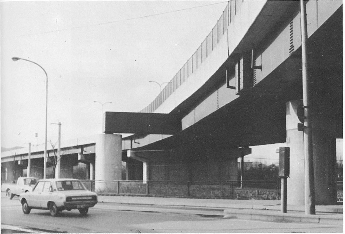
輪西跨線橋 (連續箱桁橋)
