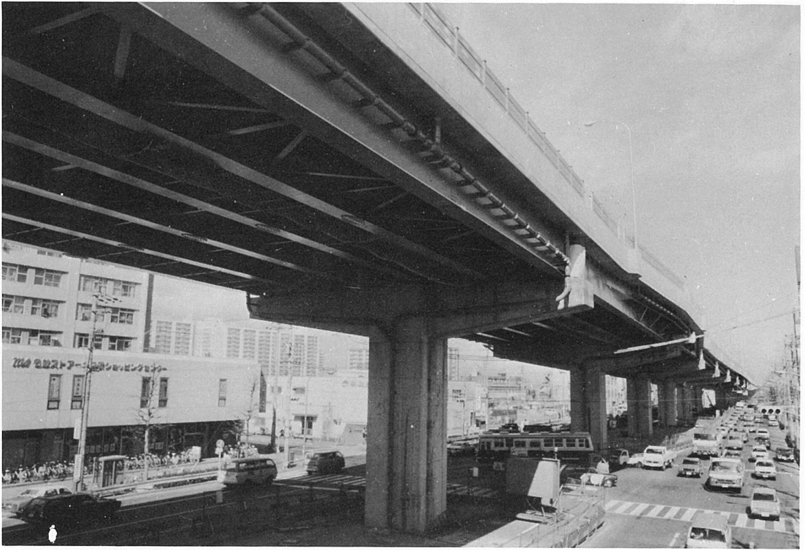
堀田北工区 (単純合成鉄桁橋)
