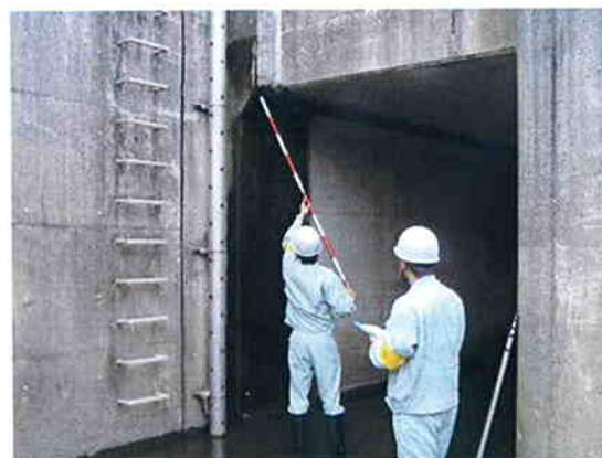
写真 4.3.2 樋門の保守点検状況
