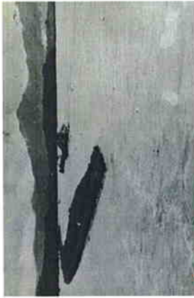
中州になった下郡築堤(大分市) 昭和 28 年 6 月洪水(梅雨前線)
