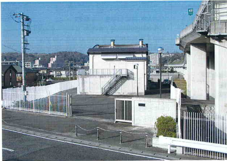
写真 1. 2. 2 尼ヶ瀬排水機場
