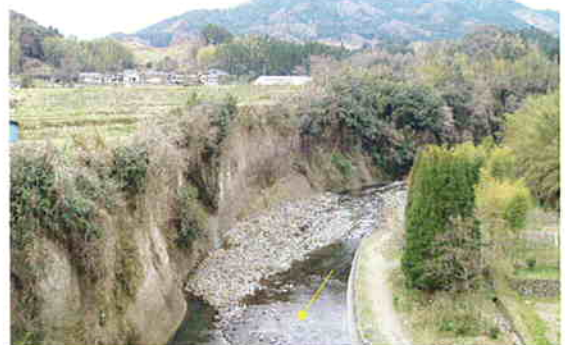
写真 1.1.2 中流部 (峡谷部)
