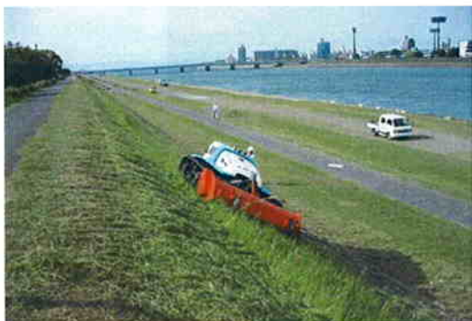
写真 4.3.4 堤防除草状況
