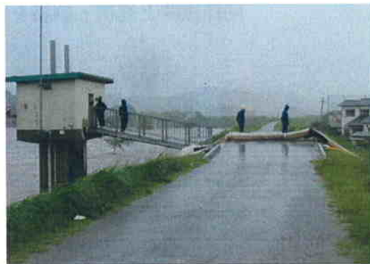
写真 4. 3. 12 緊急内水対策車による内水排除 (大分市国分地先)
