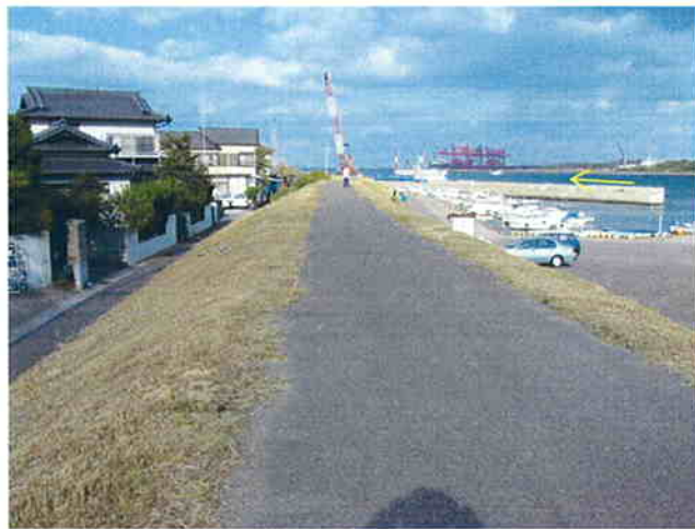
写真 2.1.1 高潮堤防状況（大分市豊海）
