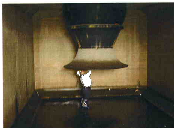
写真 4.3.3 排水ポンプの点検（尼ヶ瀬排水機場）
