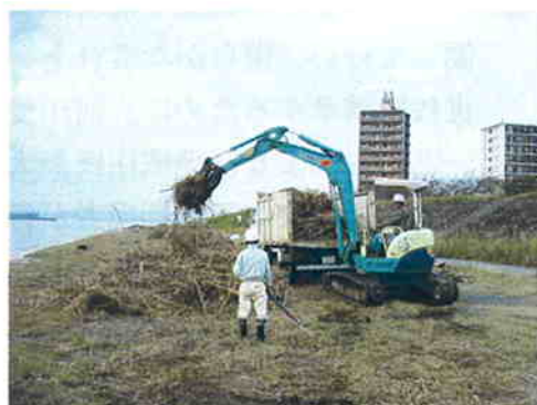
写真 4. 3. 22 流木等の撤去作業
