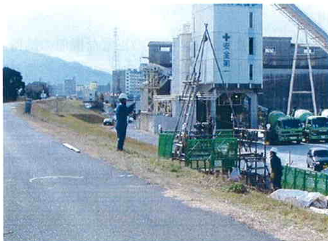
写真 4.2.1 堤防地質調査実施状況
