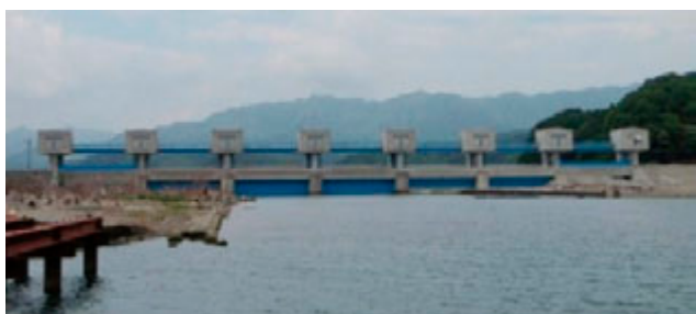
写真4.4-1 津軽石川水門の様子 1)
